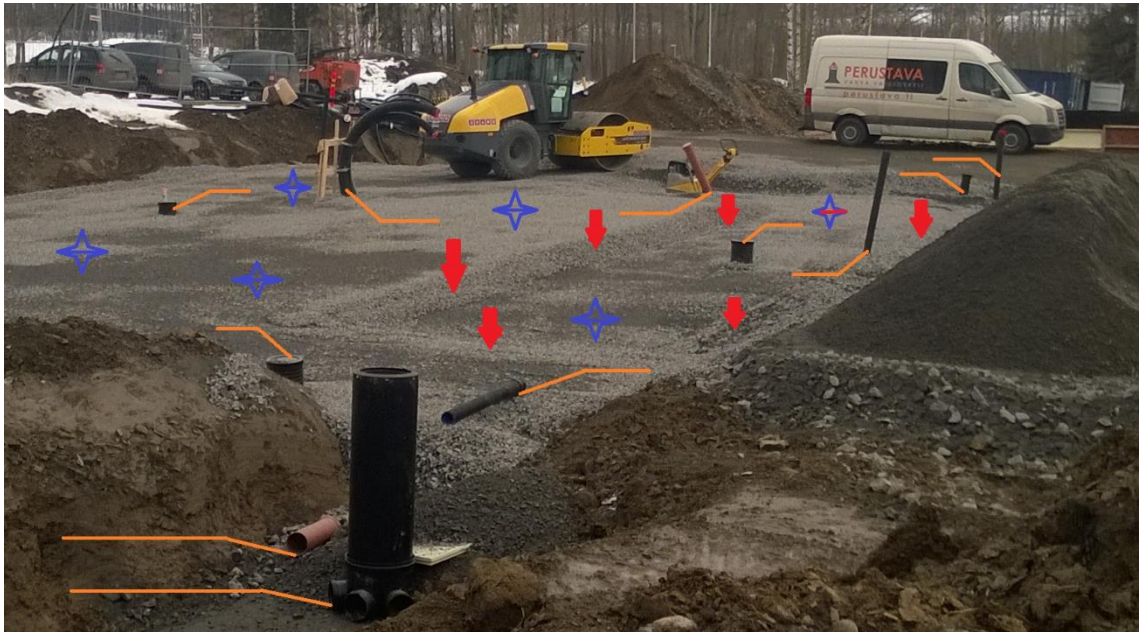
Kuvio 17. Maarakennustyömaa Tampereella
