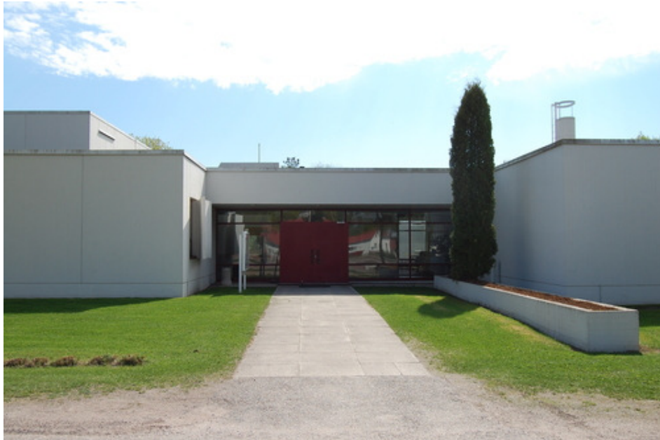
Kuva 1. Säkylään seurakuntatalo on rakennettu 1966. Ajan mukainen tasakattoinen ja ikkunayksityiskohdiltaan haastava rakennus on luokiteltu rakennushistoriallisesti merkittäväksi rakennukseksi. (Säkylä-Köyliön seurakunta n.d.)
