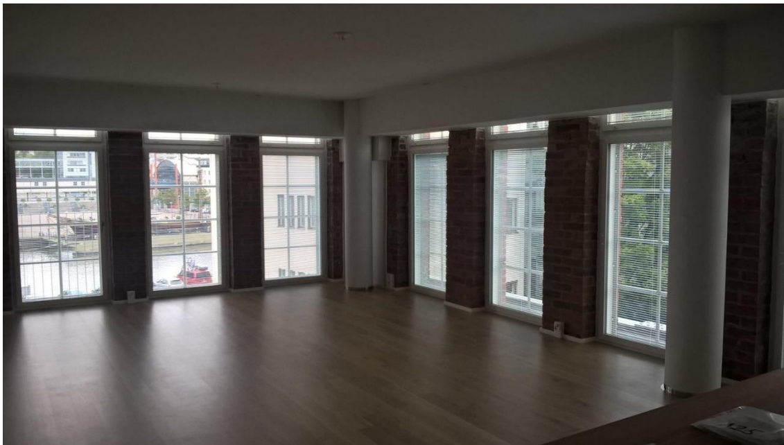
Kuva 7. Valmiin asunnon puhdistetut tiilipilarit (Jatke Oy 2017).
