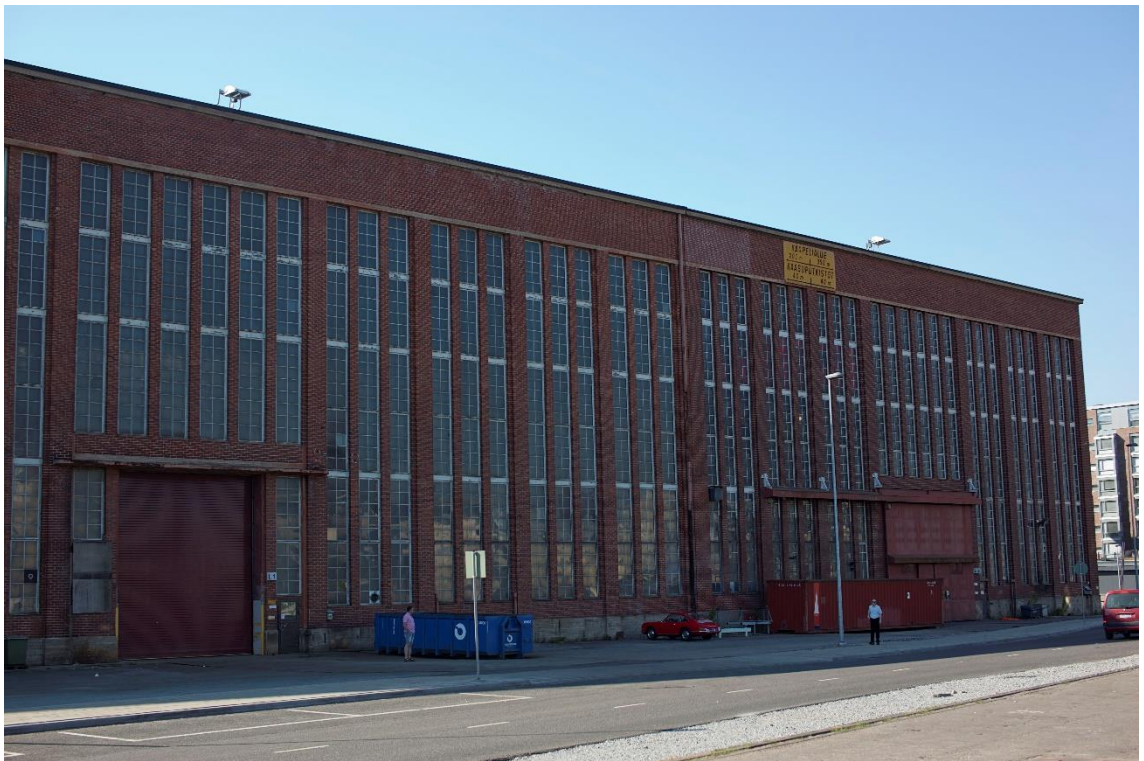
Kuva 5. Ennen töiden aloitusta (Jatke Oy 2017).
