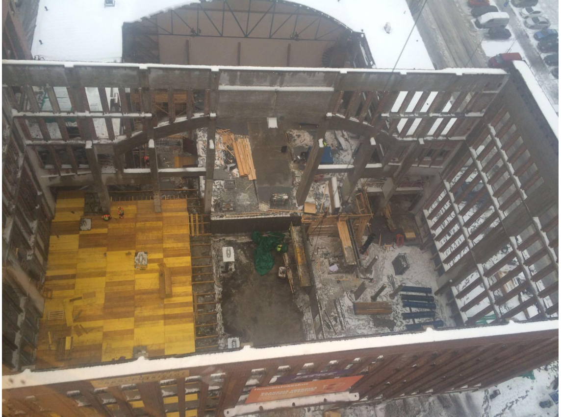
Kuva 3. Ensimmäisen kerroksen holvin laudoitus (Jatke Oy 2017).
