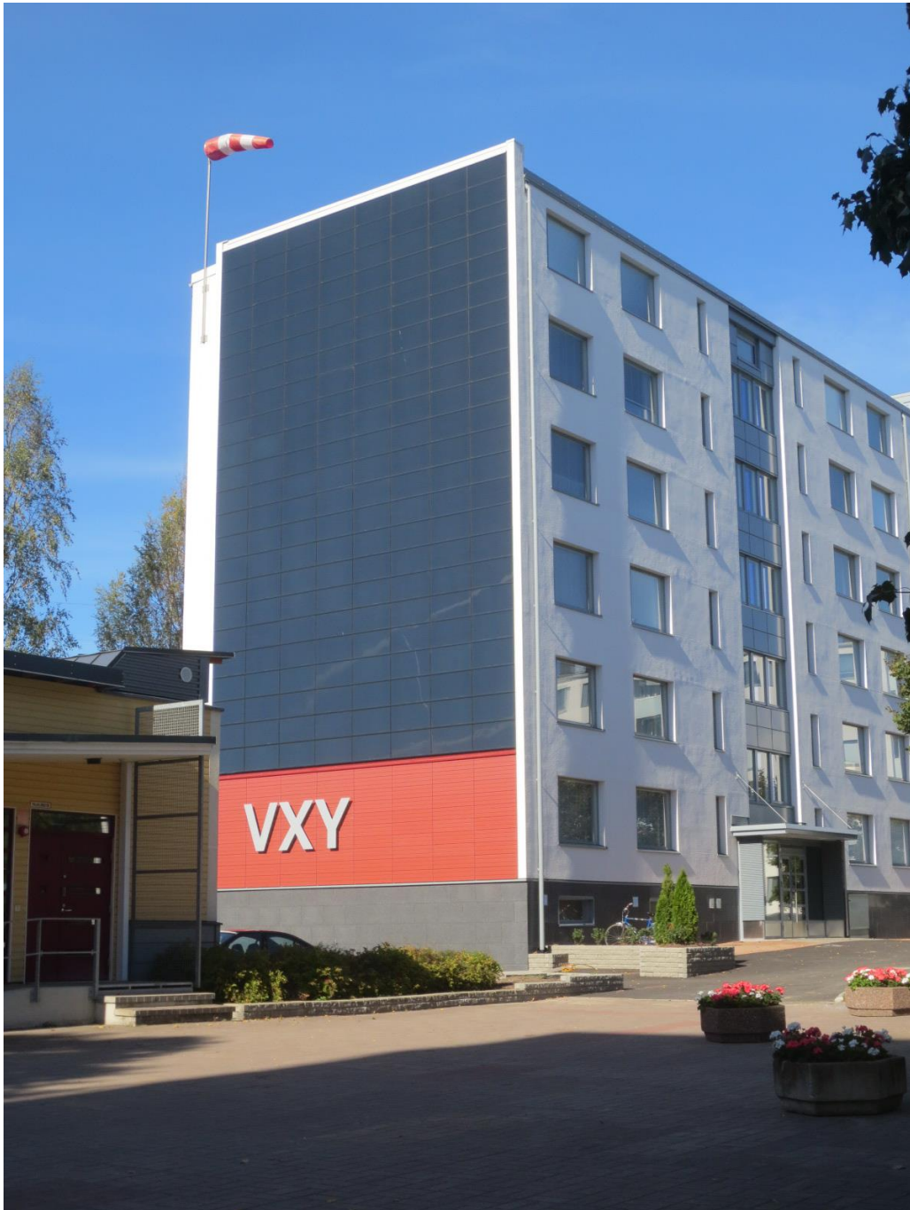
Kuva 8: Sto Ventec-Art Line aurinkopaneelien seinäasennus Jyrkkälässä
