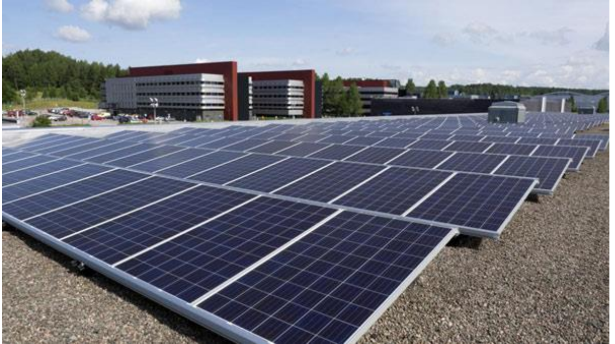
Kuva 7. Aurinkopaneelien asennus tasakatolle Salossa
