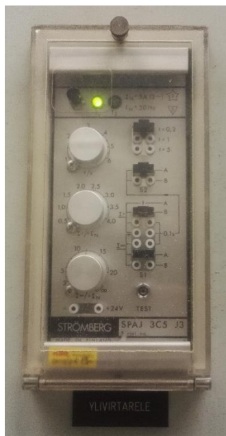
KUVA 6. Strömbergin valmistama SPAJ-sarjan suojarele (Moilanen 2017.)
