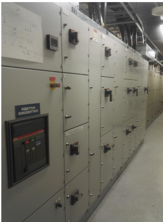
KUVA 7. Kuhmo Oy:n pääkeskus 5H (Moilanen 2017.)
