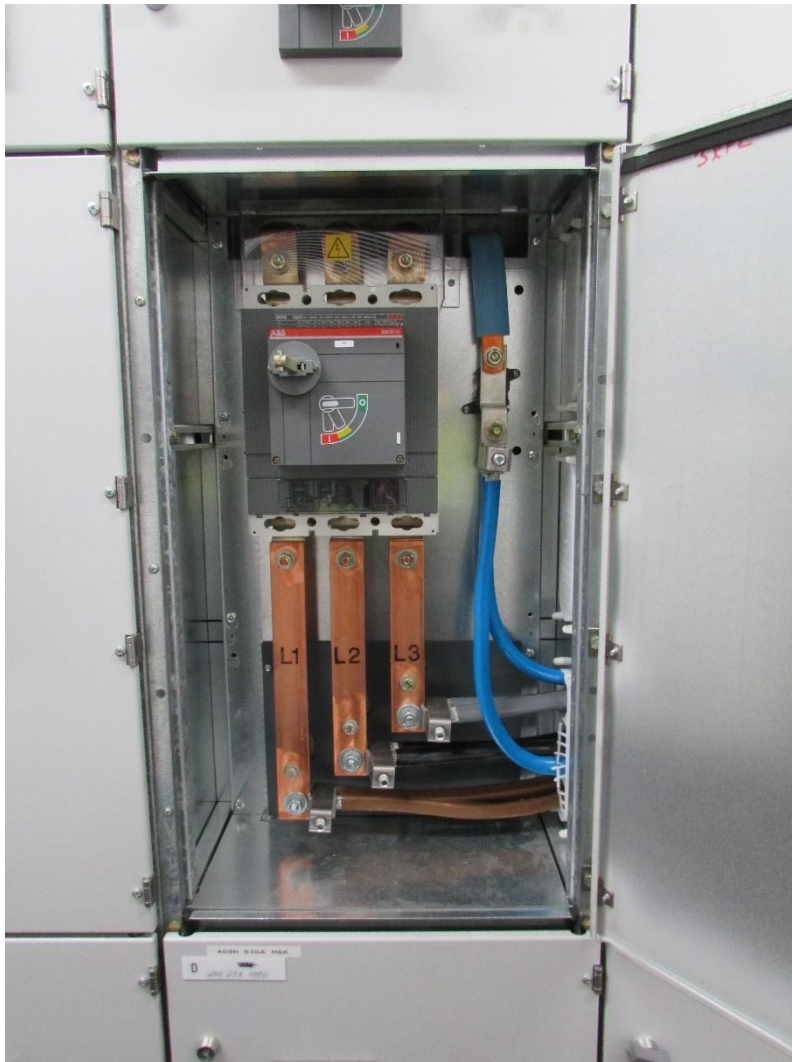
KUVA 13. ABB:n valmistama kompaktikatkaisija (Moilanen 2017.)
