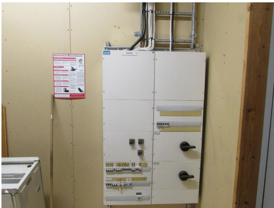
KUVA 8. Ryhmäkeskus 505H, josta tulee mm. valaistussyöttöjä (Moilanen 2017.)
