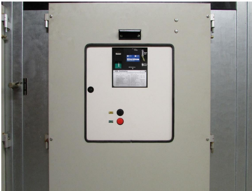
KUVA 5. Kuhmon Lämpö Oy:n Generaattorin katkaisija (Moilanen 2017.)
