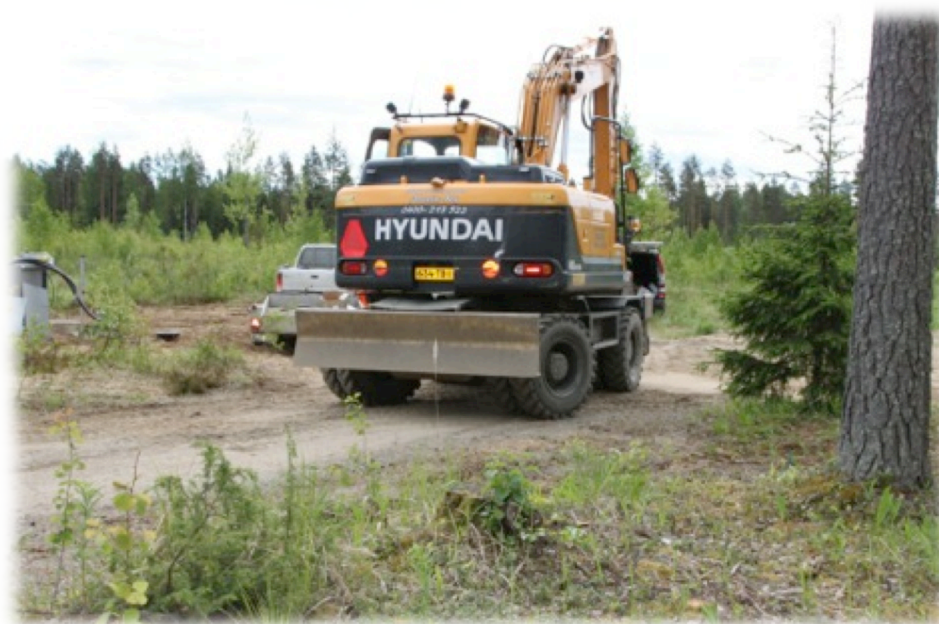
KUVA 23. Kaapelin kaivutyö pyörälustaisella kaivinkoneella 4.6.2016.
