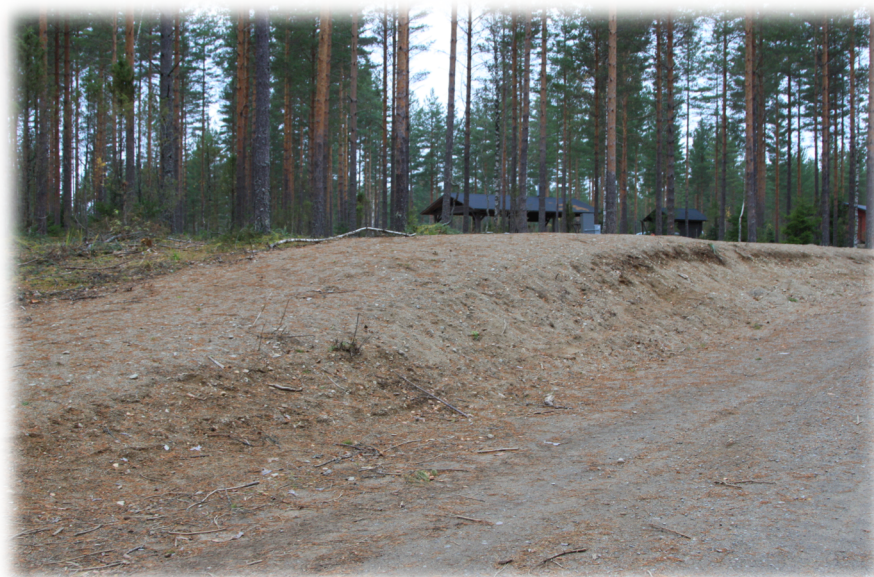
KUVA 41. Suojaamaton tien reuna
