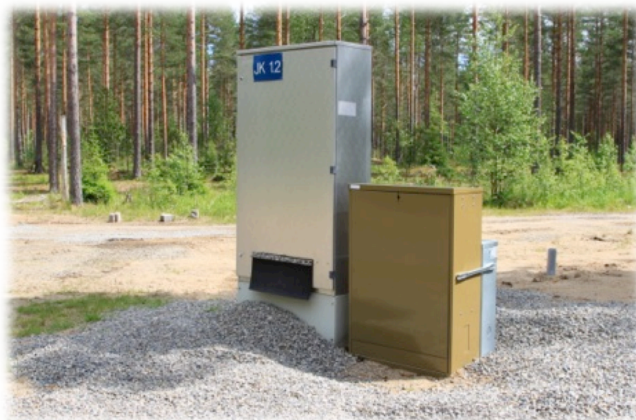
KUVA 37. Rakennus- ja purkutyöt, sähköpääkeskukset 25.6.2016
