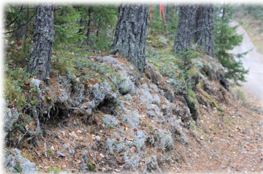
KUVA 42. Kevyellä muovinauhalla suojattu tien reuna
