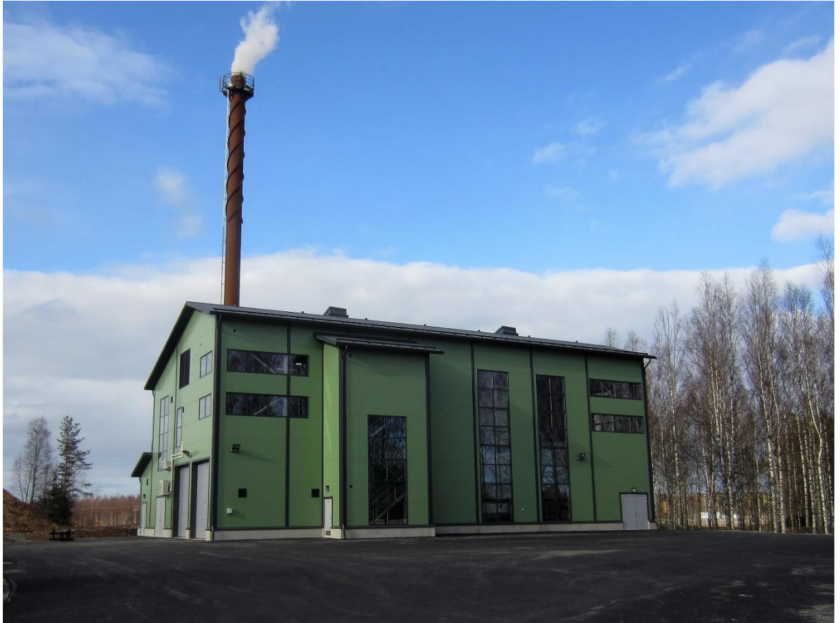
Kuva 1. Alajärven Lämpö Oy:n uusi 8 MW:n voimalaitos (Tekijän ottama valokuva).
