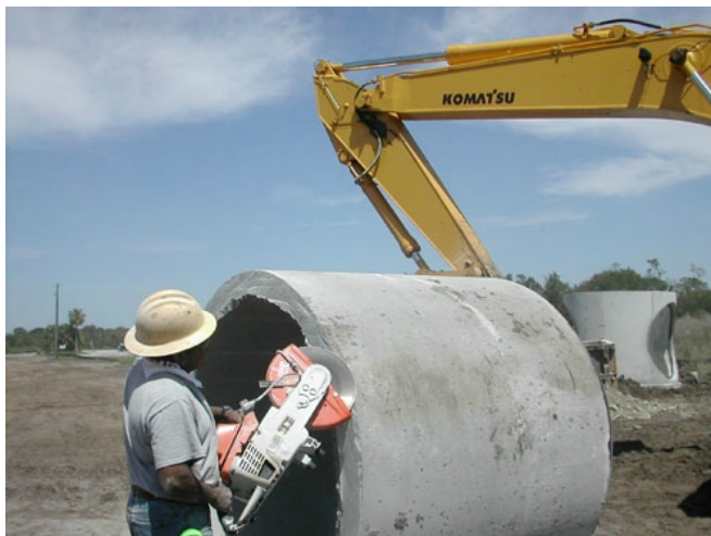
KUVA 2. Putken hiontaprosessi (ALOK 2017)
