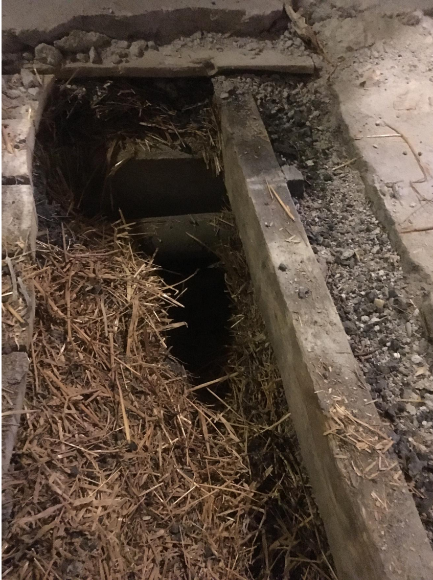
KUVA 13. Vanha eristemateriaali
