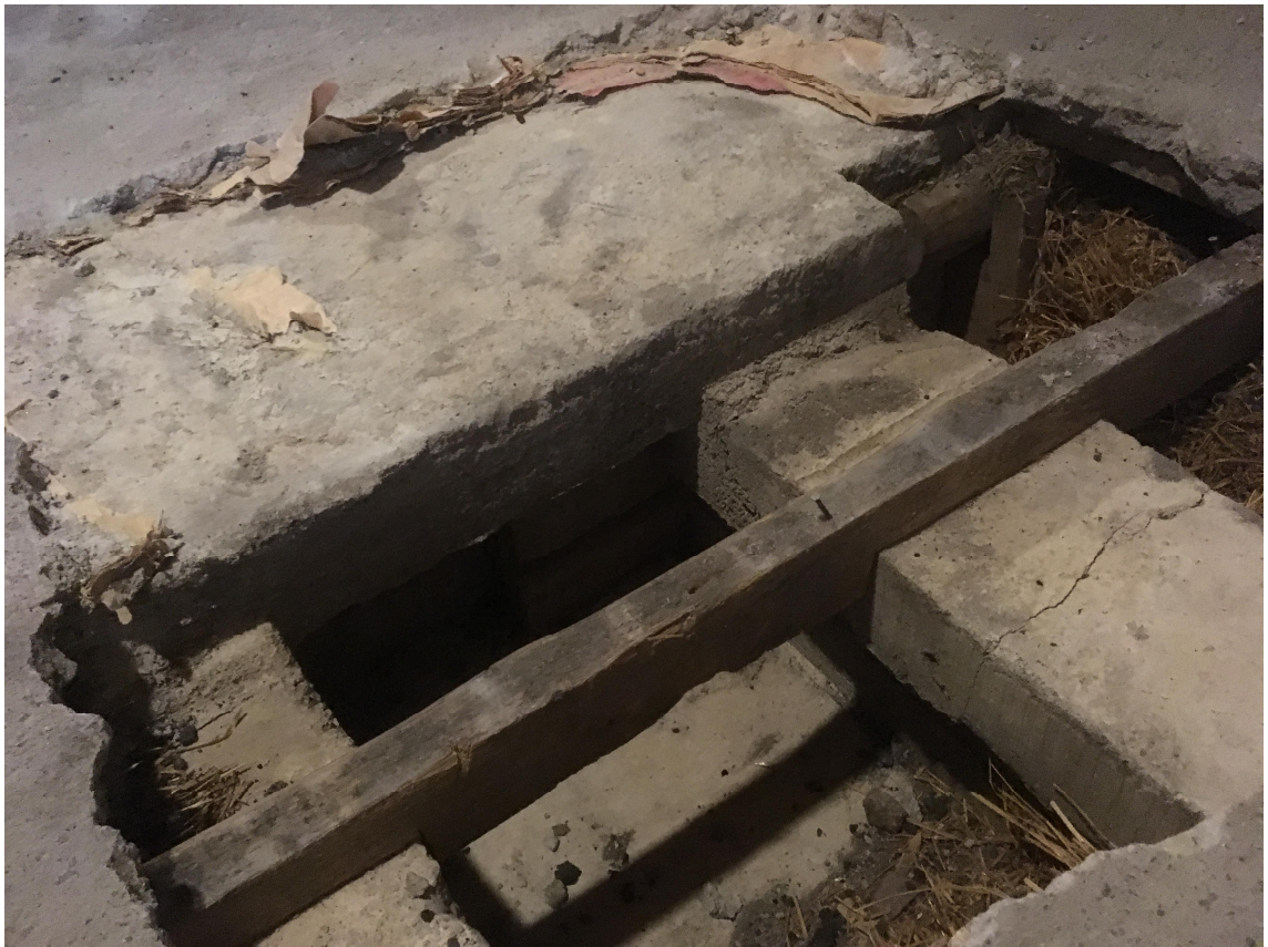
KUVA 11. Vanha alalaattapalkiston palkkirakenne
