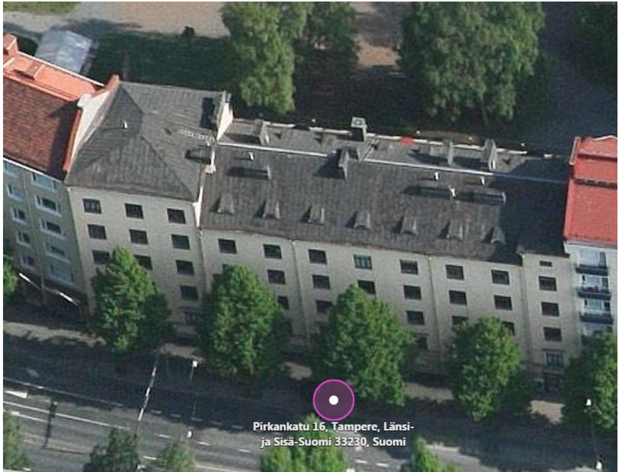
KUVA 4. Kohteen yleiskuva ennen muutostöiden aloittamista (Bing maps. 2017. https://www.bing.com/maps/ . Katsottu 27.4.2017.)
