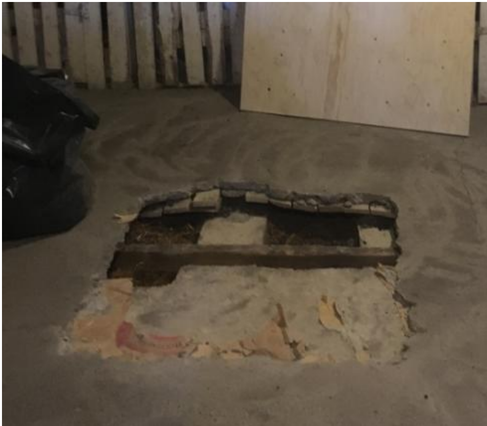
KUVA 12. Vanha primaaripalkki ja sekundaaripalkisto
