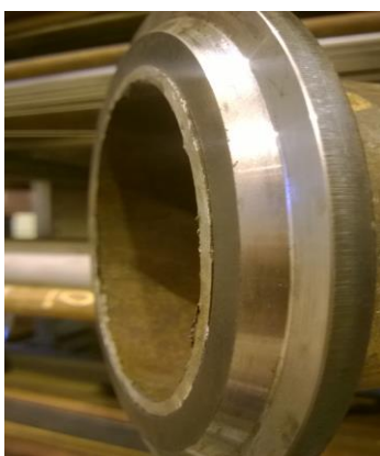
Kuva 9 Laipan asennus putken päähän (Kuva Petri Niemi)
