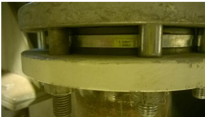
Kuva 8 Laippaliitos (Kuva Petri Niemi)
