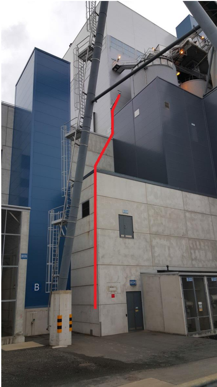
Kuva 5 Uusi putkireitti (Kuva Petri Niemi)
