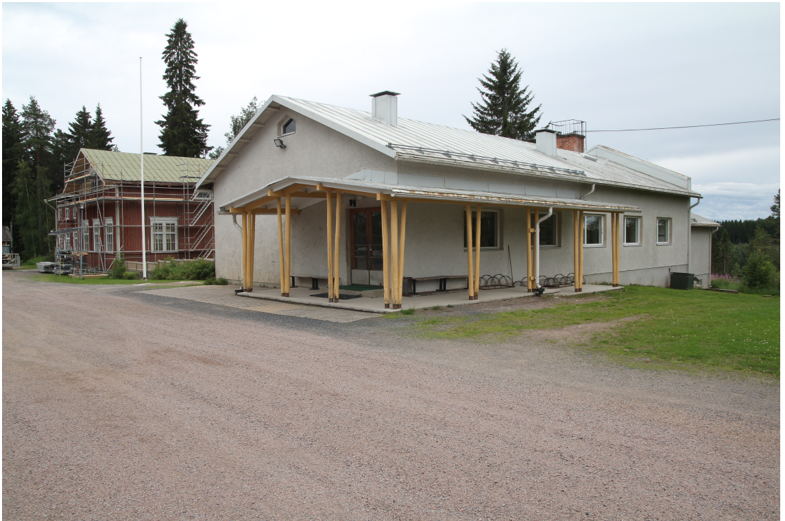
Kuva 4. Luhalahden uudempi koulurakennus
