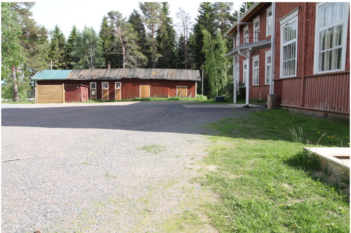
Kuva 6. Vanhemman koulurakennuksen julkisivu edestä
