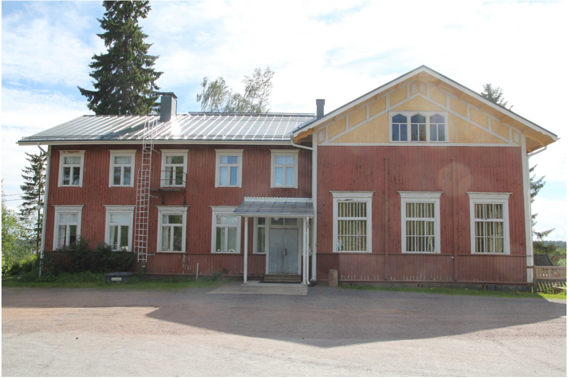
Kuva 3. Luhalahden vanhempi koulurakennus
