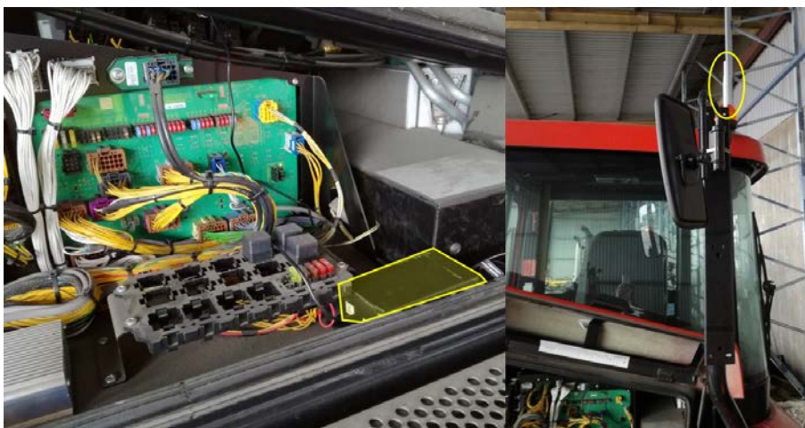
KUVA 18. Vasemmalla Terberg-terminaalitraktorin sähkökaappi ja ajoneuvopäätelaite, oikealla antennin sijoituspaikka.
