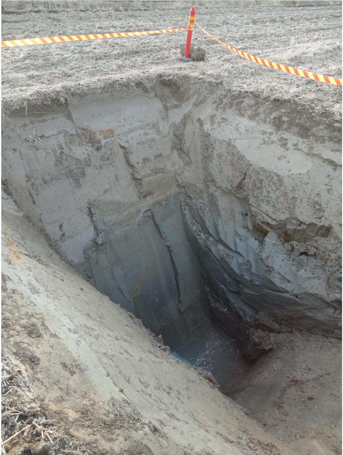
Kuva 5.7. Sisämaan kaivanto vuorokauden kuluttua kaivutyön aloittamisesta. (Heiskanen 2016)
