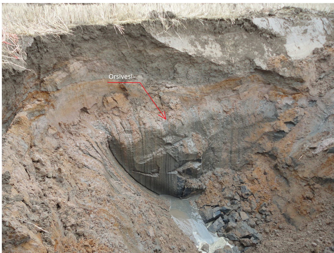
Kuva 5.4. Orsivesi purkautuu kaivantoon. (Heiskanen 2016)
