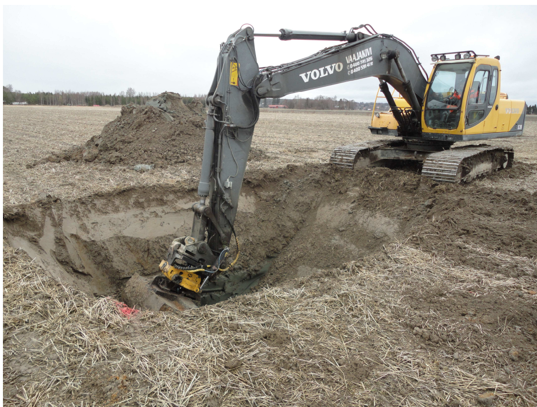
Kuva 5.2. Koekaivu työn alkuvaiheessa. (Heiskanen 2016)
