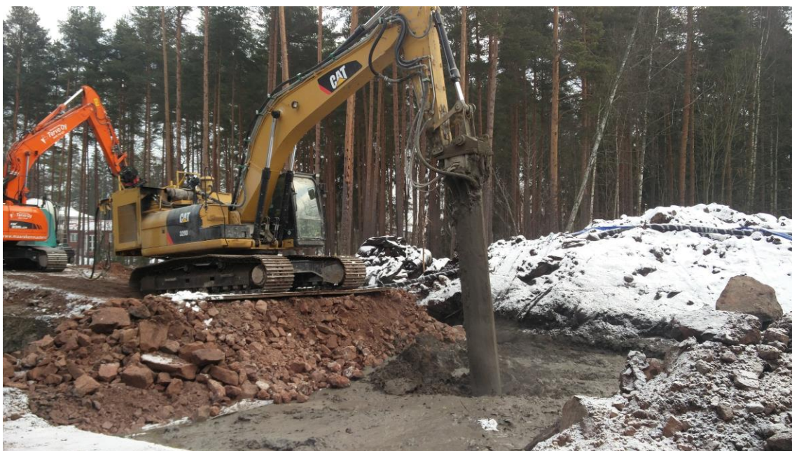
Kuva 11. Massastabilointityö käynnissä GRK:n työmaalla maaliskuussa 2017. [9.]
