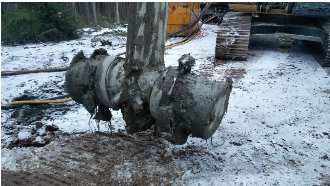
Kuva 5. Sekoitinkärki työmaaolosuhteissa GRK:n työmaalla maaliskuussa 2017. [9.]
