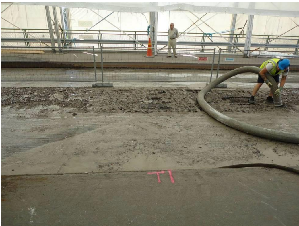
KUVA 5. Piikatur betonipinnan puhdistaminen (Liikennevirasto 2011, 10.)
