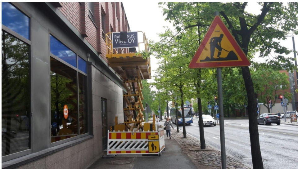
Kuva 12 Nostotyö, jolla katualueen käyttölupa (Koskela 2017)
