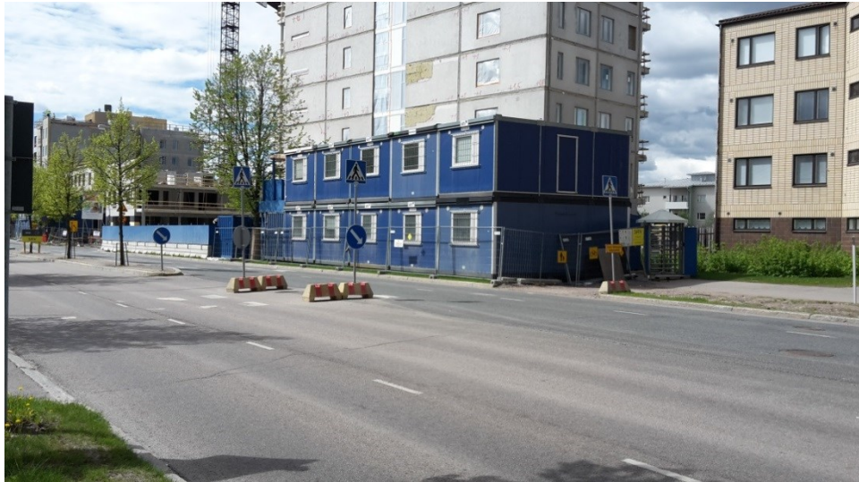
Kuva 11 Jalkakäytävä vuokrattu työmaakontteja varten ja jalankulku ohjattu tien toiselle puolelle väliaikaista suojatietä pitkin (Koskela 2017)
