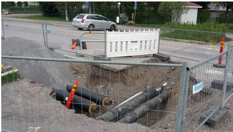
Kuva 10 Kaivutyö katualueella, jolle haettu kaivulupa (Koskela 2017)
