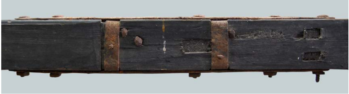
Kuva 44. Kantoaisan jatkosliitoksen raudoitus sivulta (Nyrkkö 2009).
