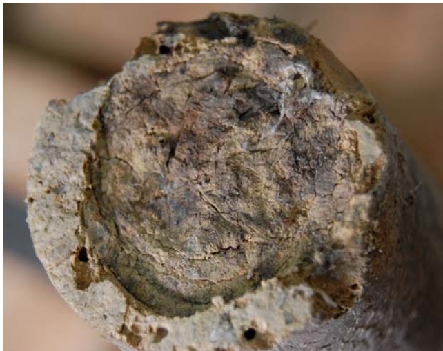
Kuva 29. Lahovaurioita jalan päässä (Nyrkkö 2009).
