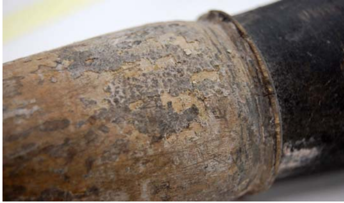
Kuva 27. Hilseilevää maalipintaa jalan päässä (Nyrkkö 2010).
