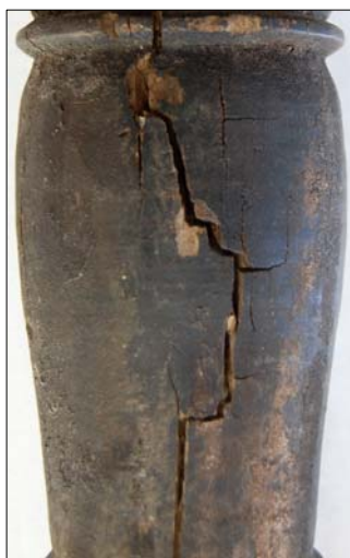
Kuva 32. Halkeama lujituksen jälkeen (Nyrkkö 2010).
