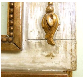
Kuva 20. Alkuperäinen harmaa liimamaali on osittain näkyvillä.
