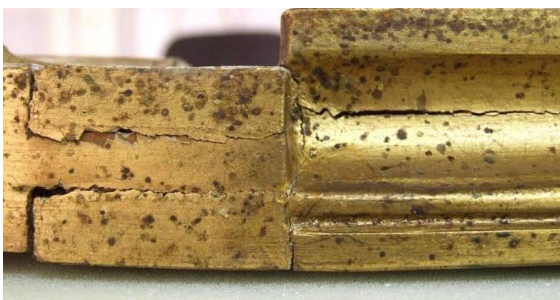
7) Vasemman ulkosivun hapettunut lyöntimetallipinta.
