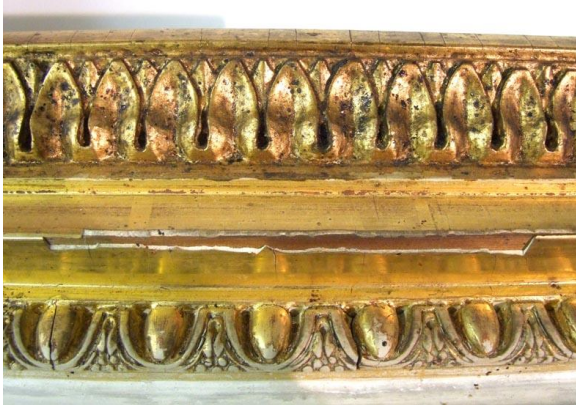
1) Yläkoristelistan aitokultapinta huonossa kunnossa.
