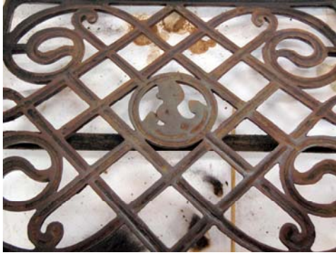
Kuva 67. Polkimen yläpuoli ennen restaurointia (Nivell 2010)
