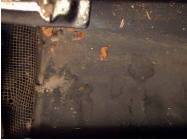
Kuva 19. Roiskesuoja sisältäpäin (Nivell 2010)
