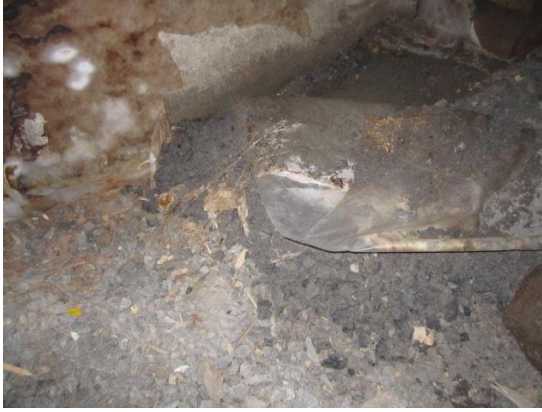
Kuva 9. Maapohjan päälle asennettu muovikalvo, rihmastoinen alapinnastaan
