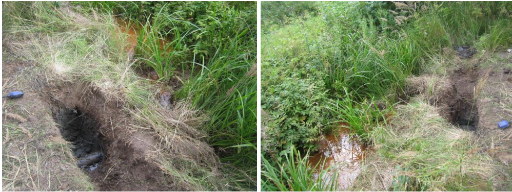
Kuva 12. Ojaan ohjatun putken pää on suhteessa vedenpintaan 20 cm alempana
