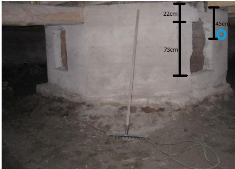
Kuva 28. Kohteessa ilmakehän korkeustaso (sininen ympyrä kuvassa) määritettiin ryömintätilassa keskellä olevien osastojen aukkojen korkeuden mukaan. Asennus suunniteltiin aukkojen 1/3-osa korkeuden mukaan ylhäältä alaspäin tarkasteltuna. Tämä siitä syystä, että linjaston alta pääsee normaaleilla huoltokäynneillä vielä tarvittaessa ryömimään ja ilmaa saadaan kuitenkin ohjattua suuttimista osastojen sisään
