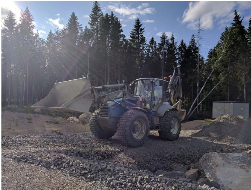
Kuva 16. KKT kaivurikuormaaja rakentamassa työmaaliittymää
