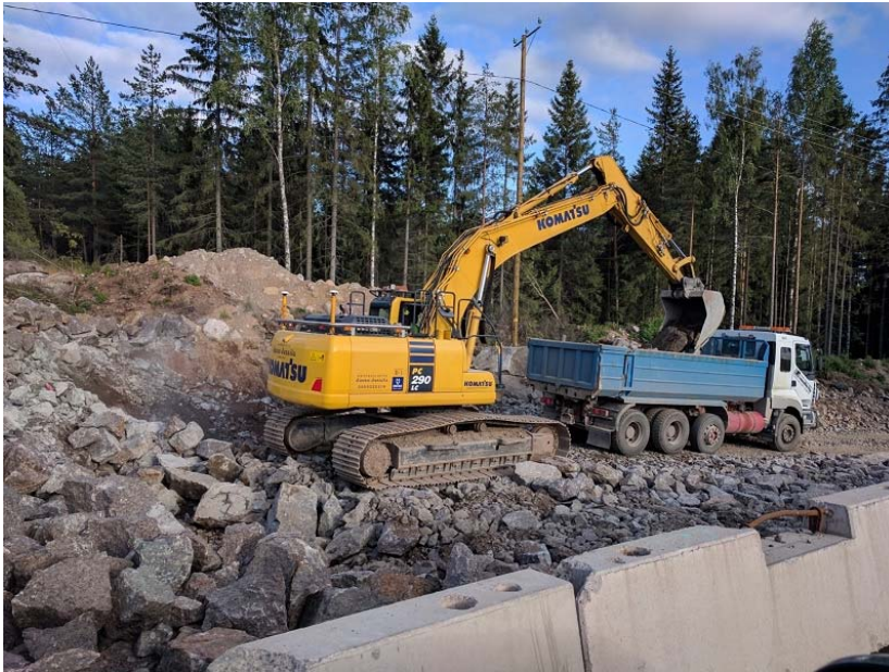
Kuva 14. KKHT tela-alustainen kaivinkone lastaamassa kuorma-autoa
