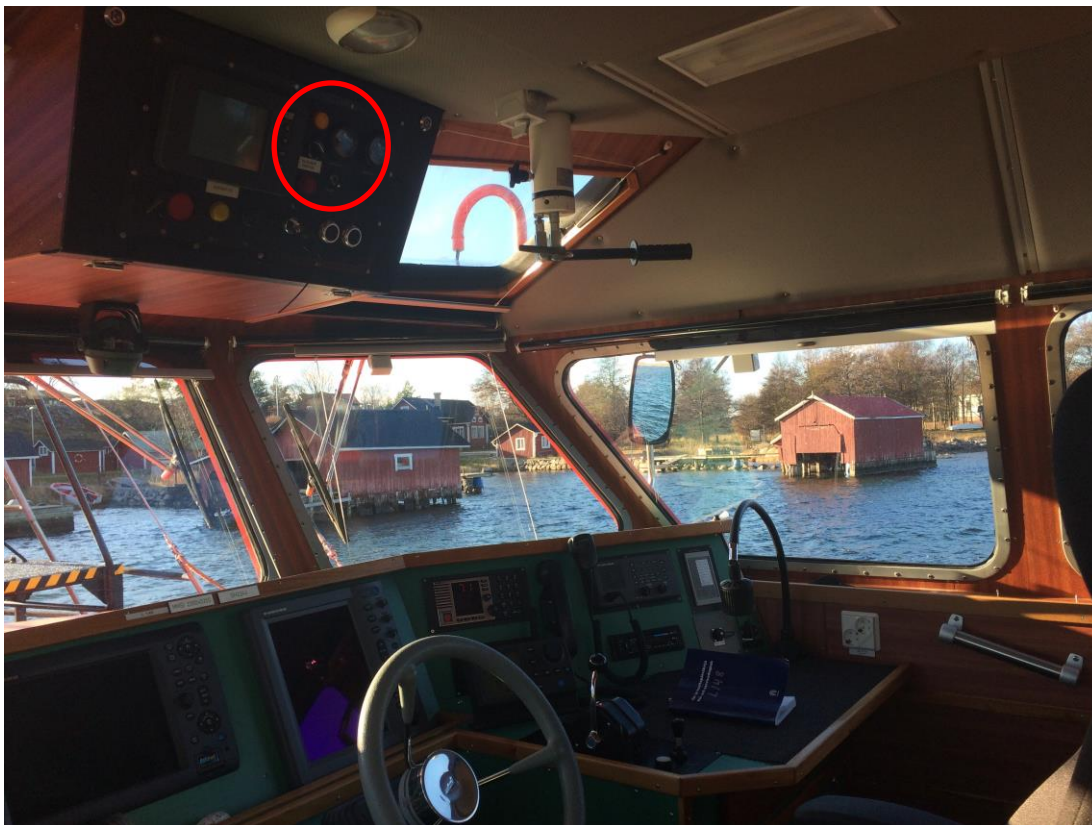
Kuva 14 Koneistoautomaation suojausjärjestelmien ohituskytkin luotsikutteri L-148 (rak. 2012) ohjaamossa. Kytkin on sijoitettu kuljettajan yläpuolelle katossa olevaan koneiston valvontapaneeliin. Kytkintä ei ole suojattu kannella tahattoman käytön estämiseksi. L-148 on hidaskulkuinen, jääajoon tarkoitettu alus, mutta ohjaamo ja sen järjestely ei merkittävästi poikkea vastaavankokoisen, nopeakulkuisen aluksen ohjaamosta.
