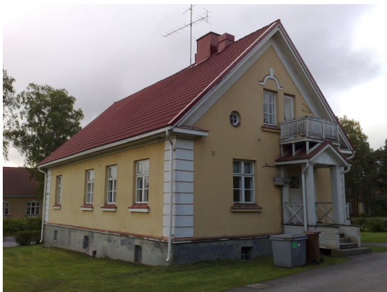
Kuva 1. Opinnäytetyön kohde pohjoisesta
