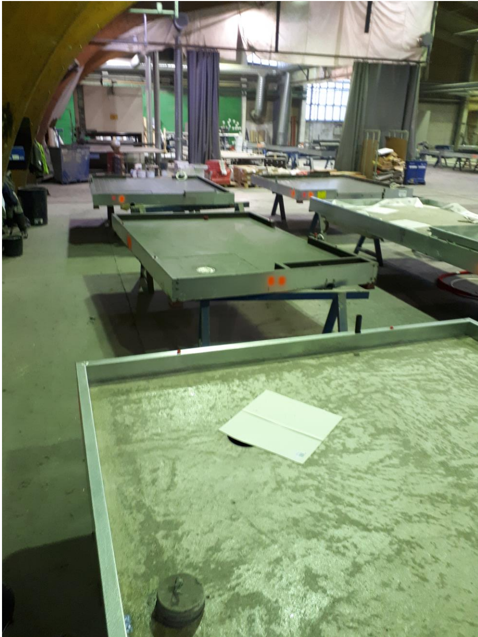
Kuva 6. Pohjalaattojen vesieristys ja laatoitus tehtaalla.
