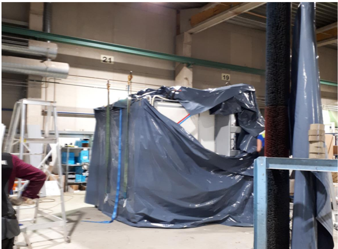
Kuva 14. Kylpyhuone-elementin suojamuovitus on kohta valmis Forssan tehtaalla
