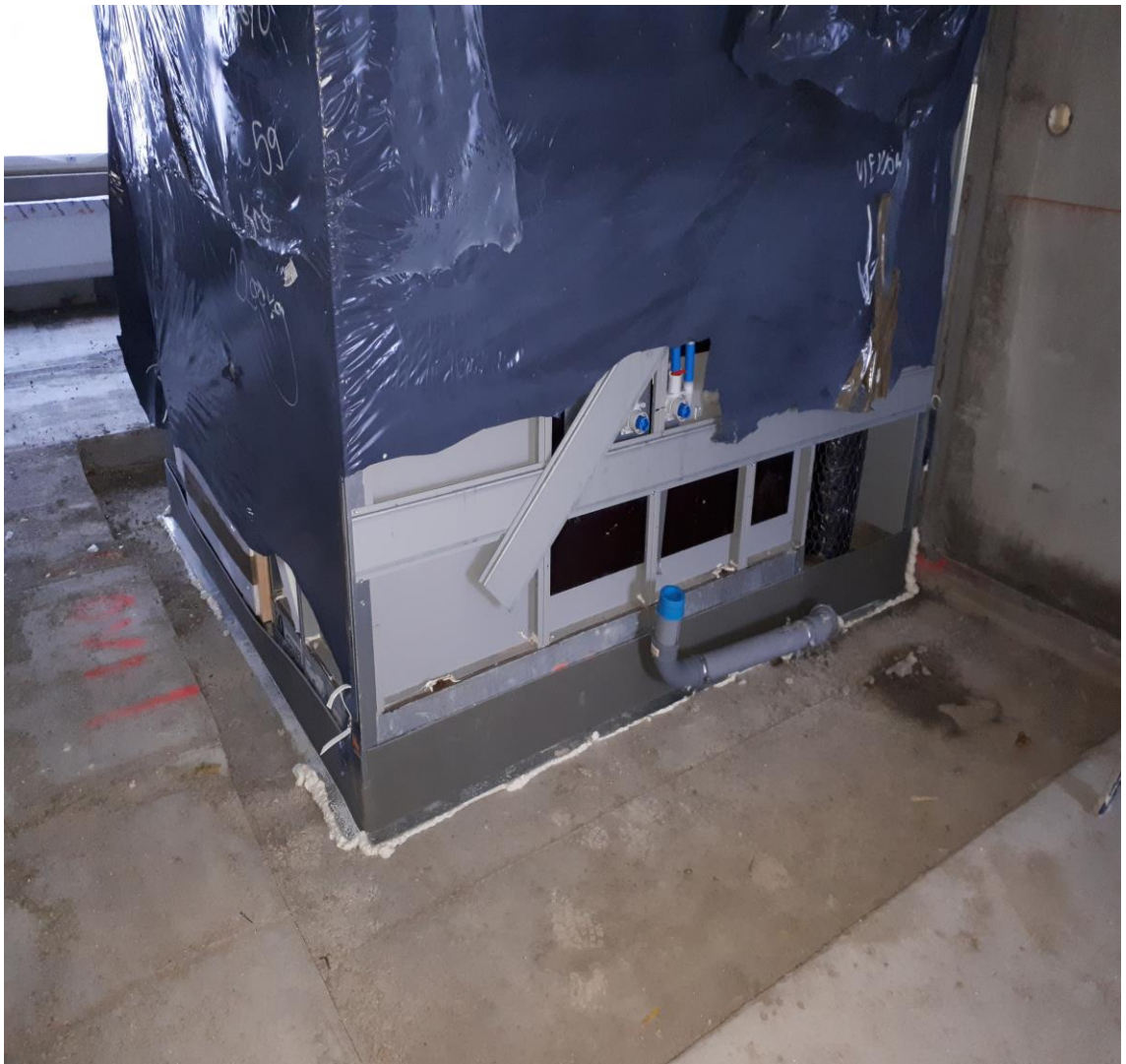
Kuva 13. Kaikki on valmista kylpyhuone-elementin osalta reunavalua varten.
