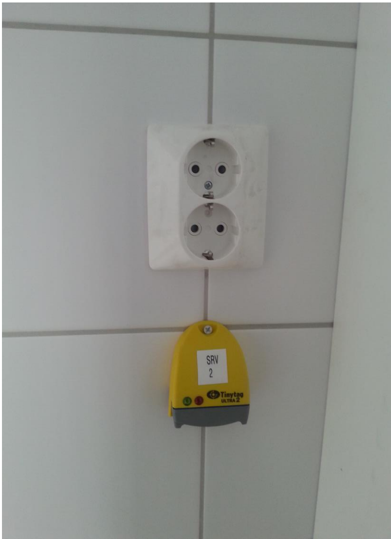
Kuva 3. Loggeri asennuttuna elementtikylpyhuoneen seinään tehtaalla.
