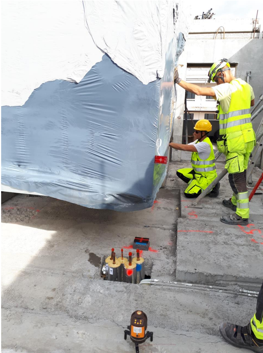
Kuva 12. Asennustyö on käynnissä Suurpellon työmaalla. Huomaa ristilaser ja vastaanottolevy.
