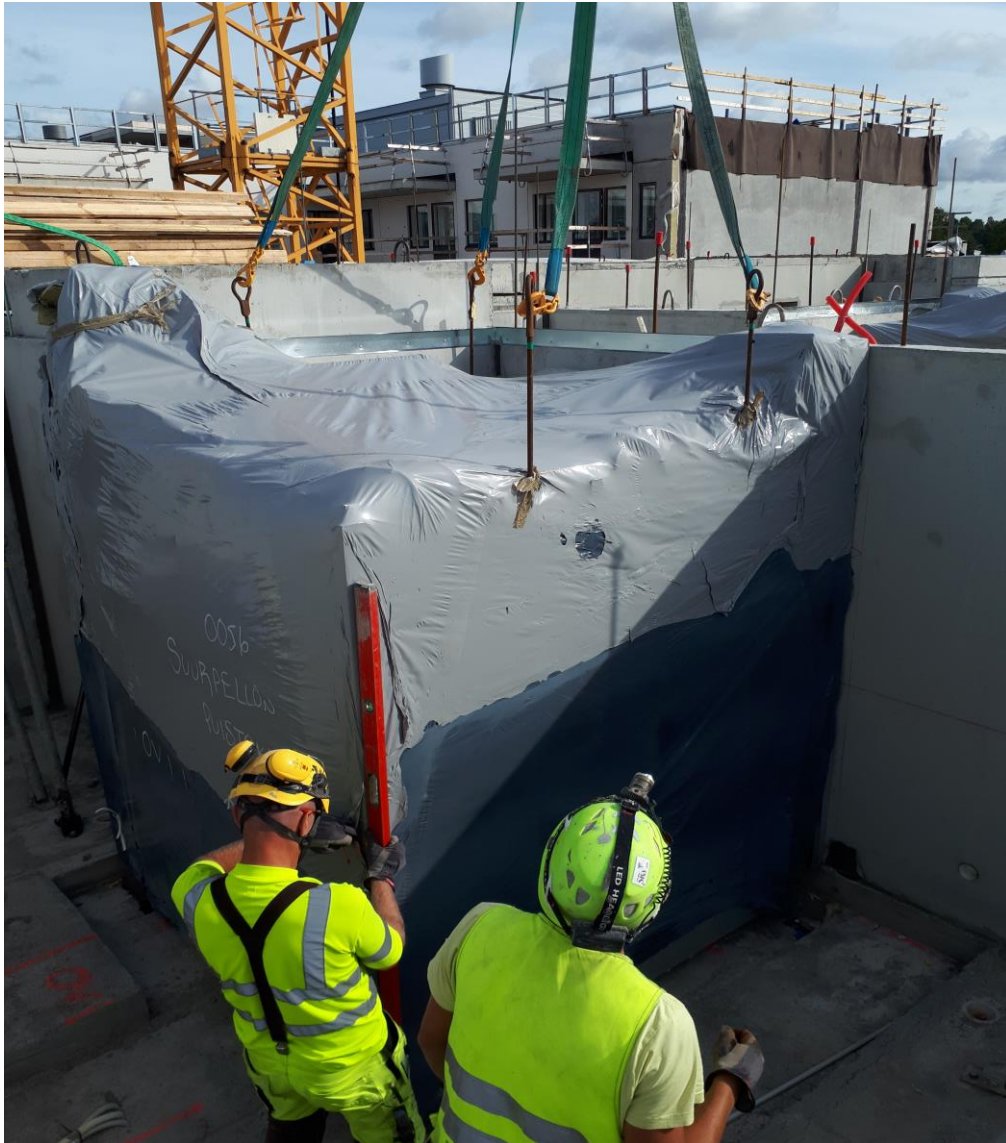
Kuva 15. Kylpyhuone-elementin asennus on käynnissä kantavien seinien sisänurkkaan
