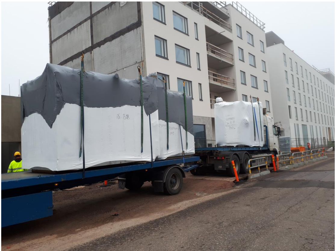
Kuva 11. Kiinnitysliinat on laitettu muovin sisään. Ne tulevat helposti pois rikkomatta muovia
