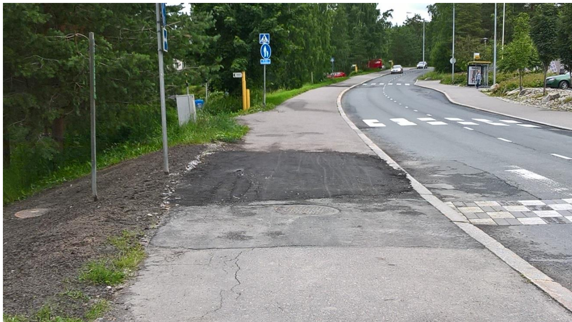
Kuva 3. Pehmeä asfalttibetonimassa (PAB) laitettuna kaukolämpökaivantoon (Kosunen 2017–7–26)
