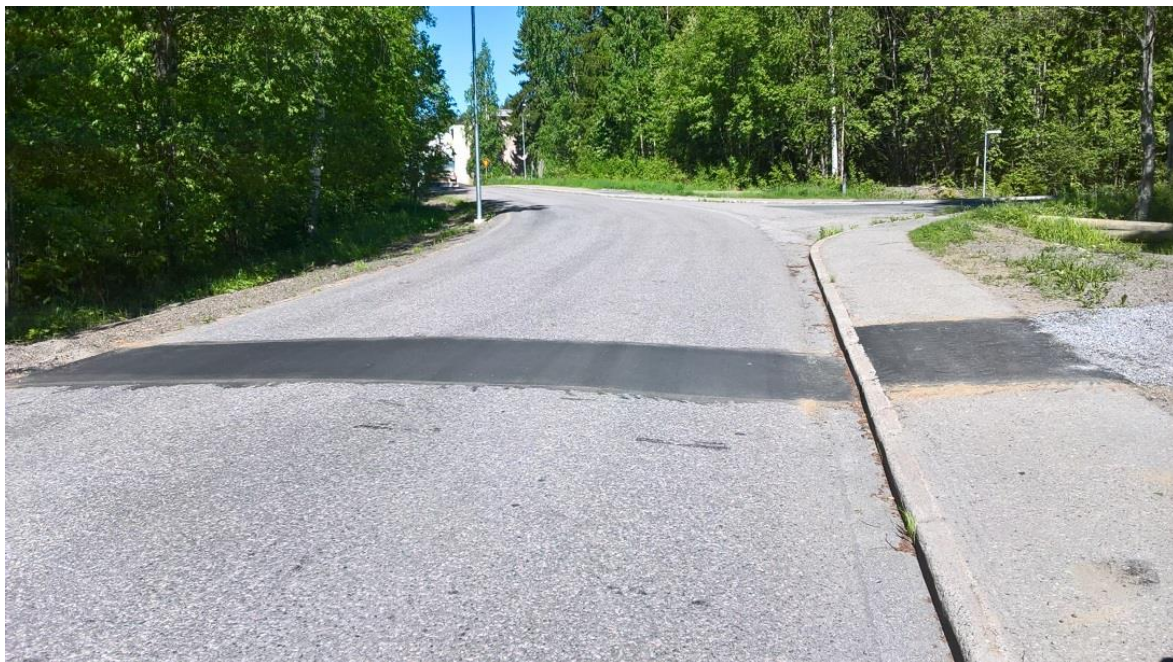
Kuva 8. Päällystetty kaukolämmön kaivanto (Kosunen 2017–6-15)
