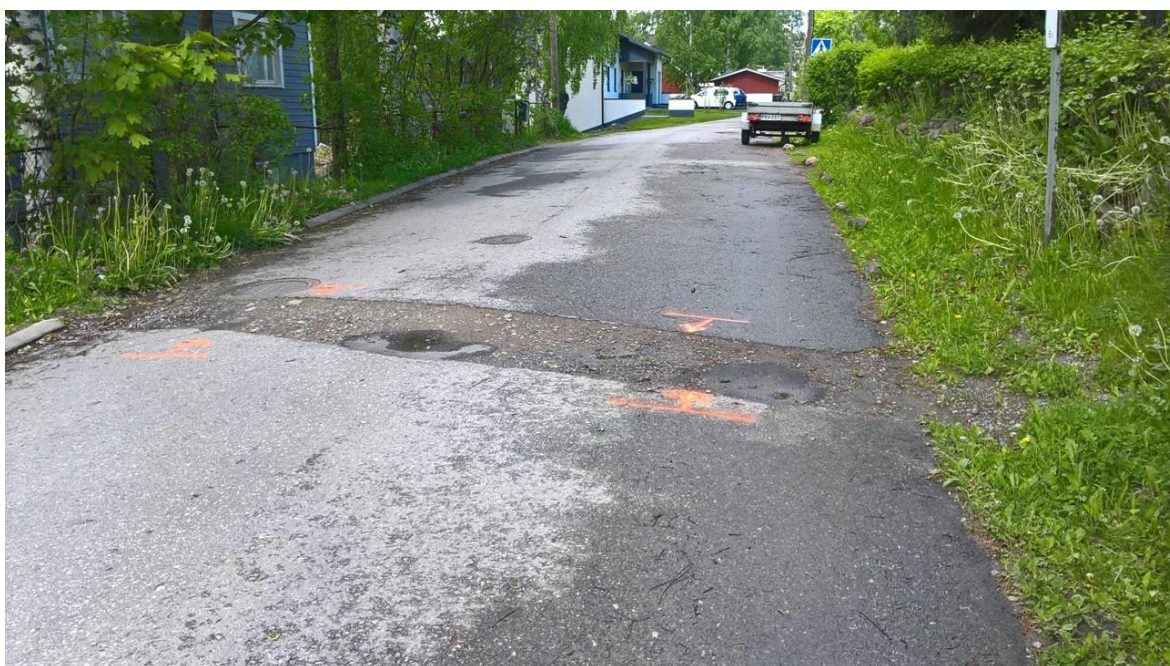
Kuva 2. Sähköjohtoa varten katuun kaivettu roilo (Kosunen 2017–6–26)
