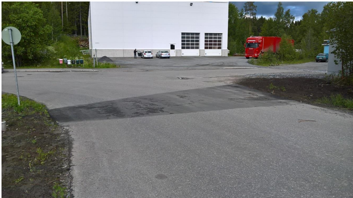
Kuva 5. Kaarroksen mukaisesti paikattu kohde (Kosunen 2017-6-26)
