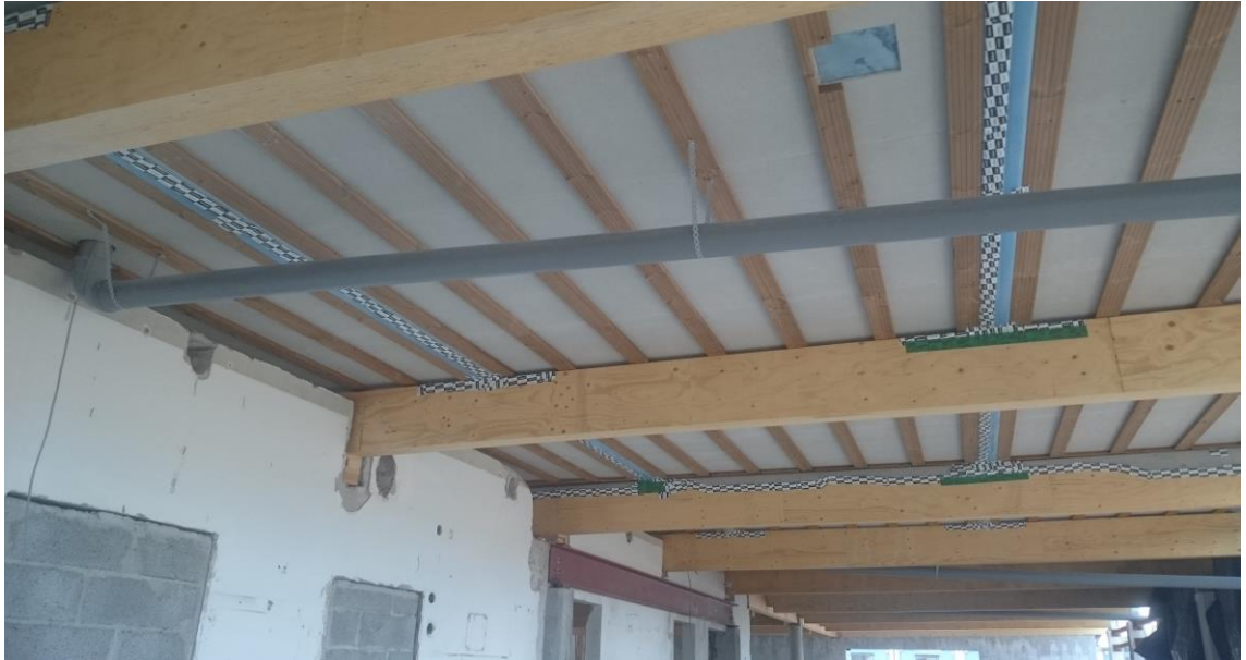
Kuva 12. Väliaikainen vedenpoisto kattokaivoilta.
