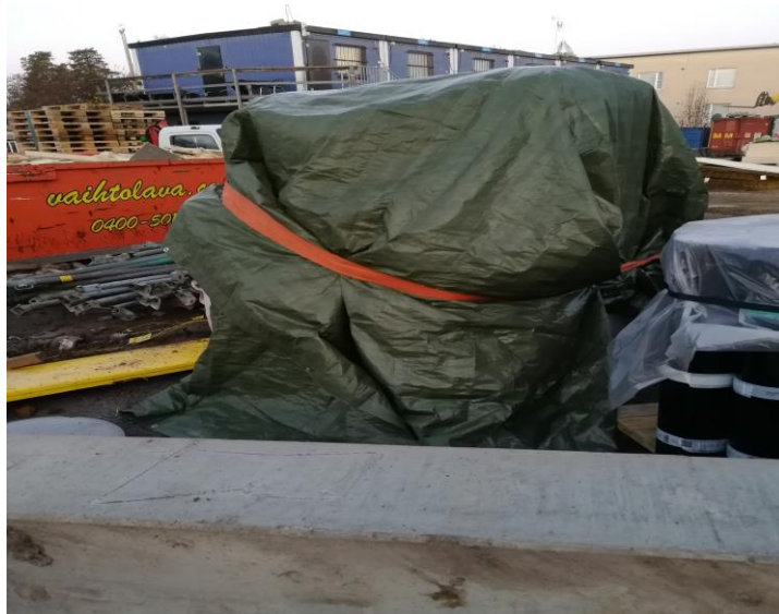
Kuva 13. Materiaalit suojattuina kevytpeitteillä.
