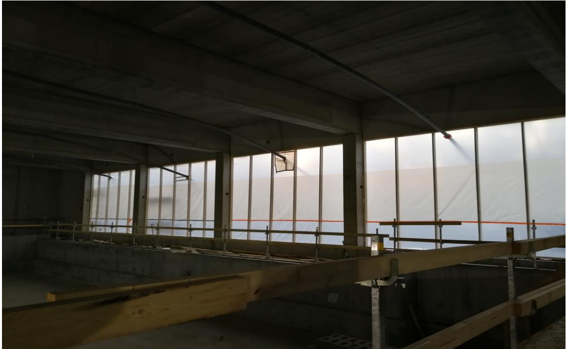
Kuva 15. Allasosaston suuret ikkuna-aukot suojattuna.
