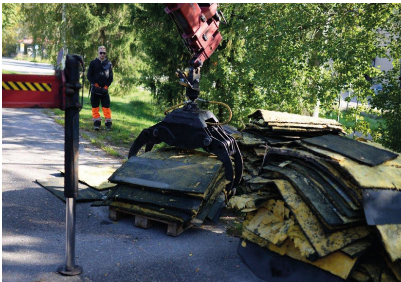
KUVA 2. Tarpaper jalostaa kierrätetystä kattohuovasta asfaltin raaka-ainetta. Kuva: Jani Vehviläinen
