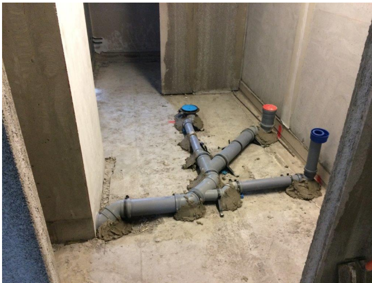
Kuva 2. Kaivon sekä viemäreiden vahvistaminen betonilla ennen raudoitusta ja valua [13.]
