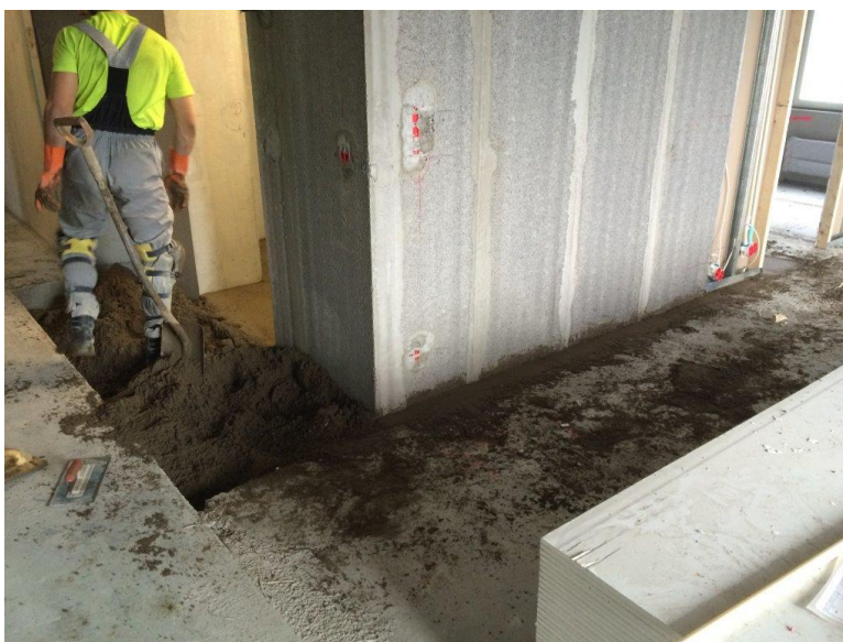
Kuva 9. Estrich-betonointi käynnissä. Kuvassa näkyy pian työstettävää massaa sekä valmis kolotäyttö. [13.]
