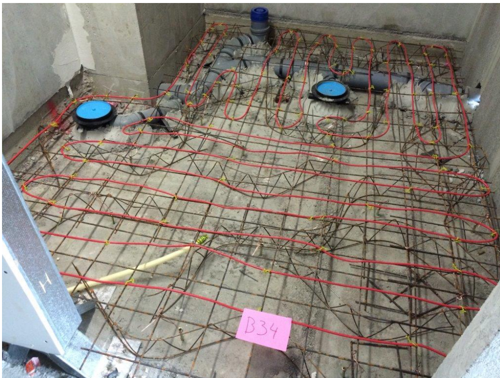
Kuva 5. Kaikkien valmistelevien työvaiheiden jälkeen kylpyhuone näyttää tältä. Jokaisessa kuvassa tulee näkyä huoneiston numero dokumentoinnin helpottamiseksi. [13.]
