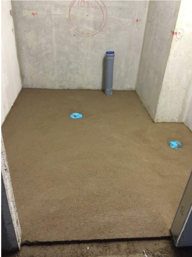
Kuva 1. Metrikorko seinällä jo valetussa kylpyhuoneessa [13.]
