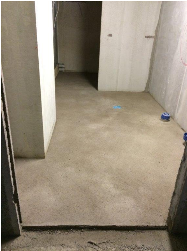
Kuva 7. Valmis kylpyhuoneen kaatolattiavalu [13.]
