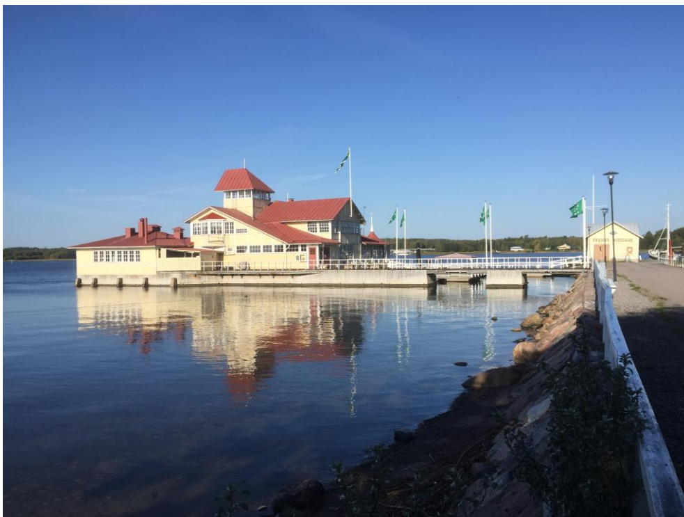
Bild 3. Ett landmärke för Ekenäs. Knipan är byggd på pålar i vattnet. (Dennis Lindroos 24.9.2017)
