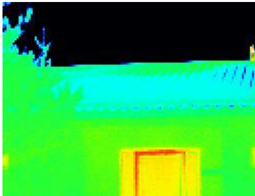
Kuva 3. Lavian kiinteistön lämpökuva (Mäkelä 2017).
