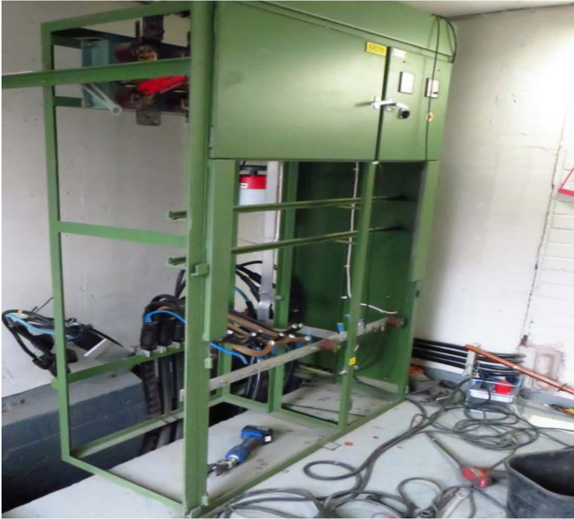
KUVA 12 Pienjännitekeskuksen purku
