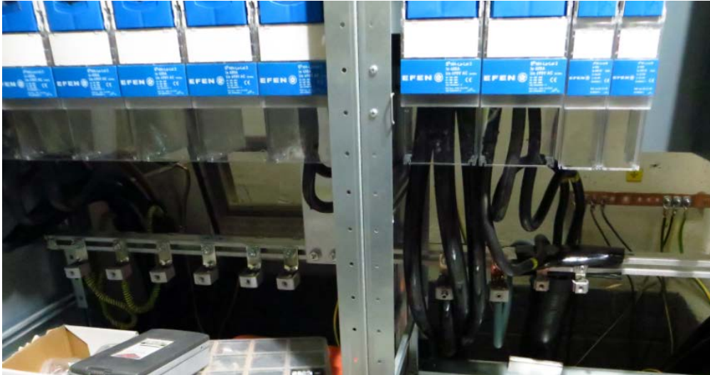
KUVA 29 Pienjännitekaapeleiden kääntö
