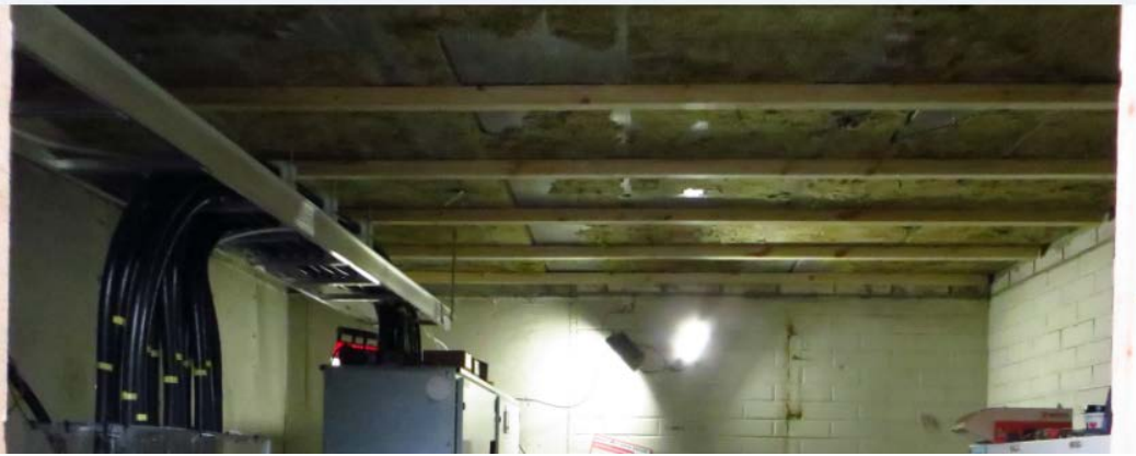
KUVA 27 Katto eristeen puukoolaus
