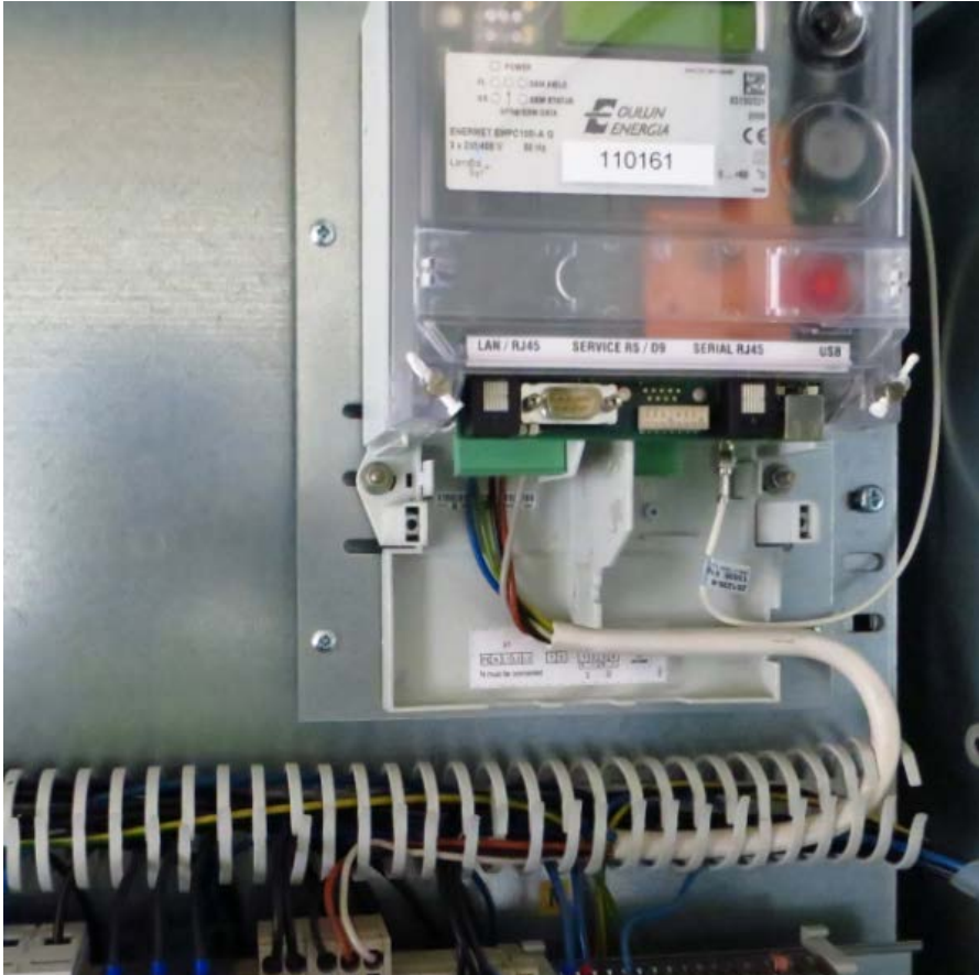
KUVA 25 Etäluettavan keskittimen asennus
