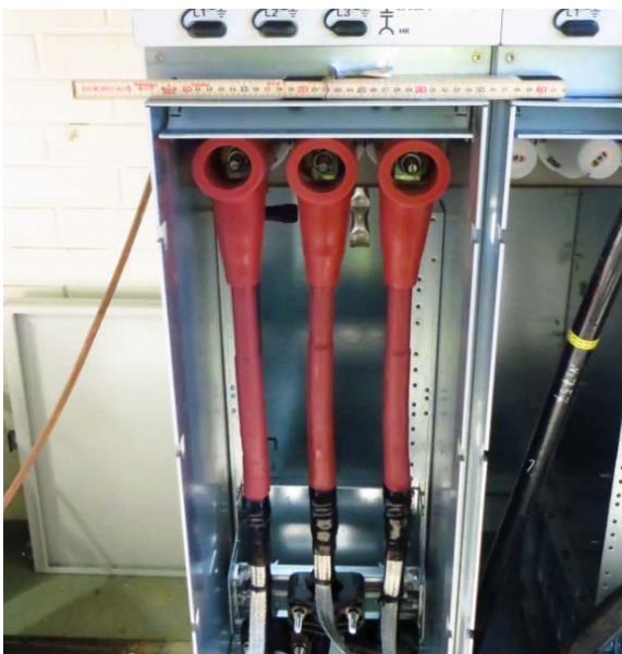
KUVA 22 Keskijännitekaapelit kojeistossa
