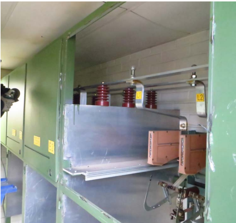
KUVA 10 Keskijännitekojeiston paloittelu
