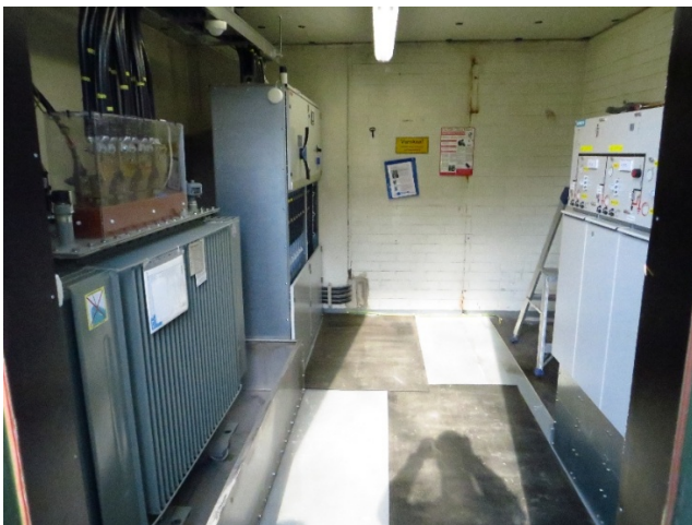
KUVA 3. Kiinteistömuuntamo
