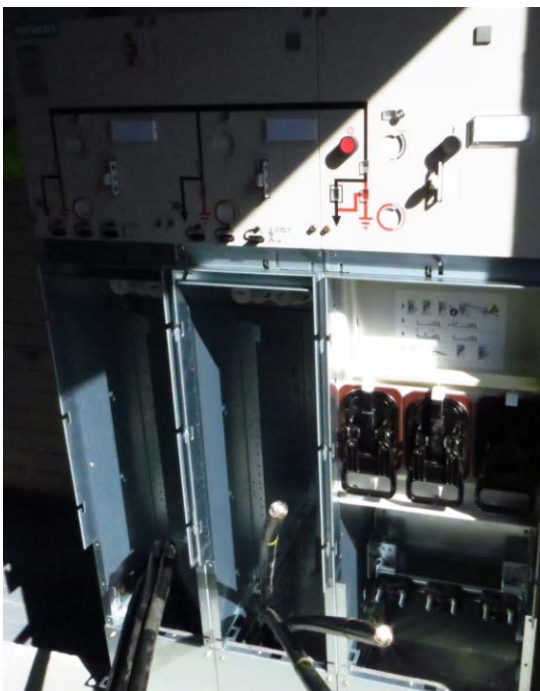
KUVA 19 Keskijännitekojeisto paikoillaan
