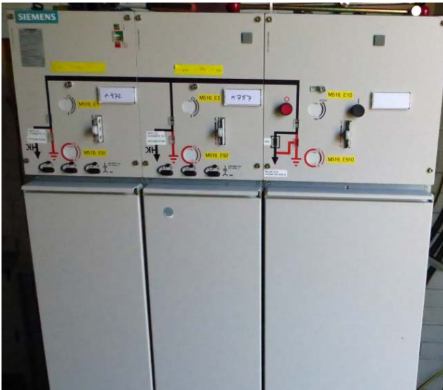
KUVA 23 Keskijännitekojeisto suljettuna
