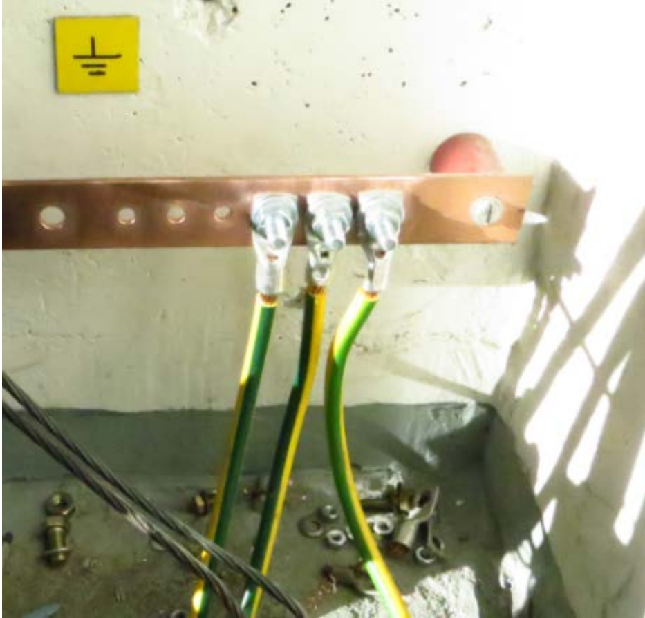
KUVA 15 Uusien maadoitusten valmistelu
