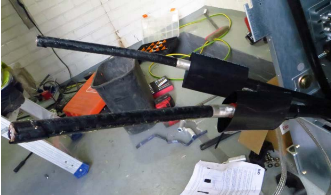
KUVA 21 Keskijännitekaapeleiden päätteiden valmistus
