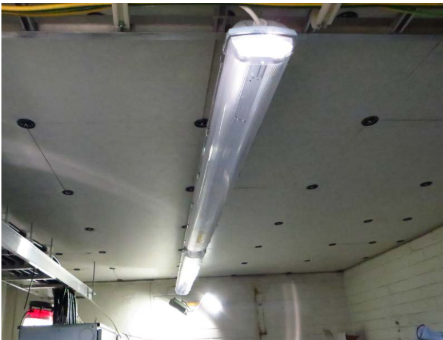
KUVA 28 Eristelevyt sekä valaistuskisko
