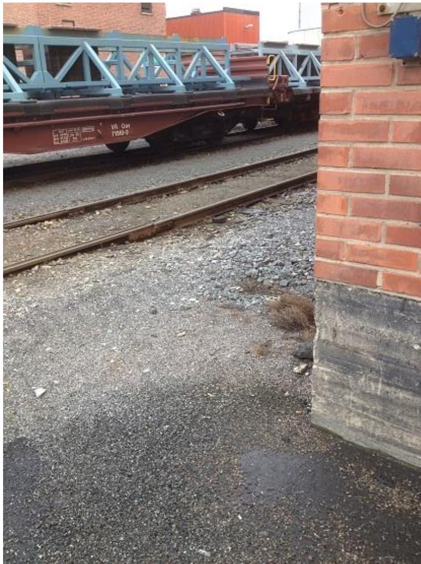
Kuva 8 Raiteet rakennuksen vieressä
