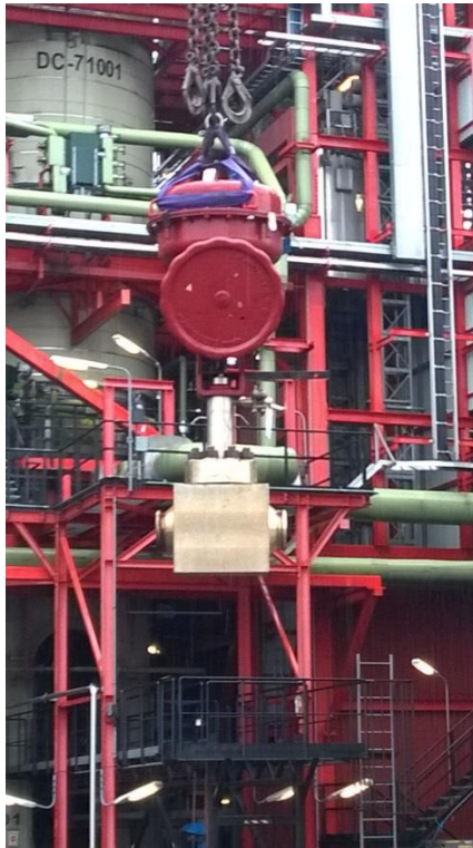
KUVA 3. Venttiilin nostoa TL4:llä
