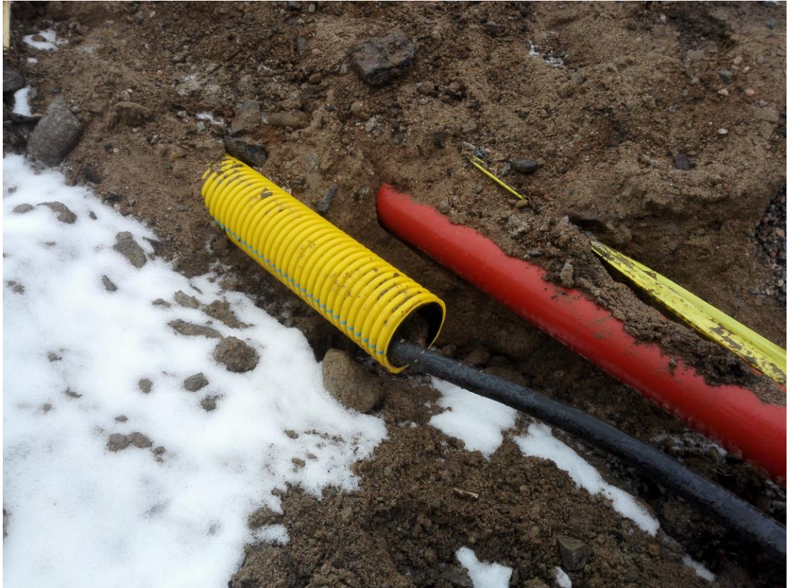
Kuva 9. Pienjännitemaakaapeli asennettuna suojaputkeen.
