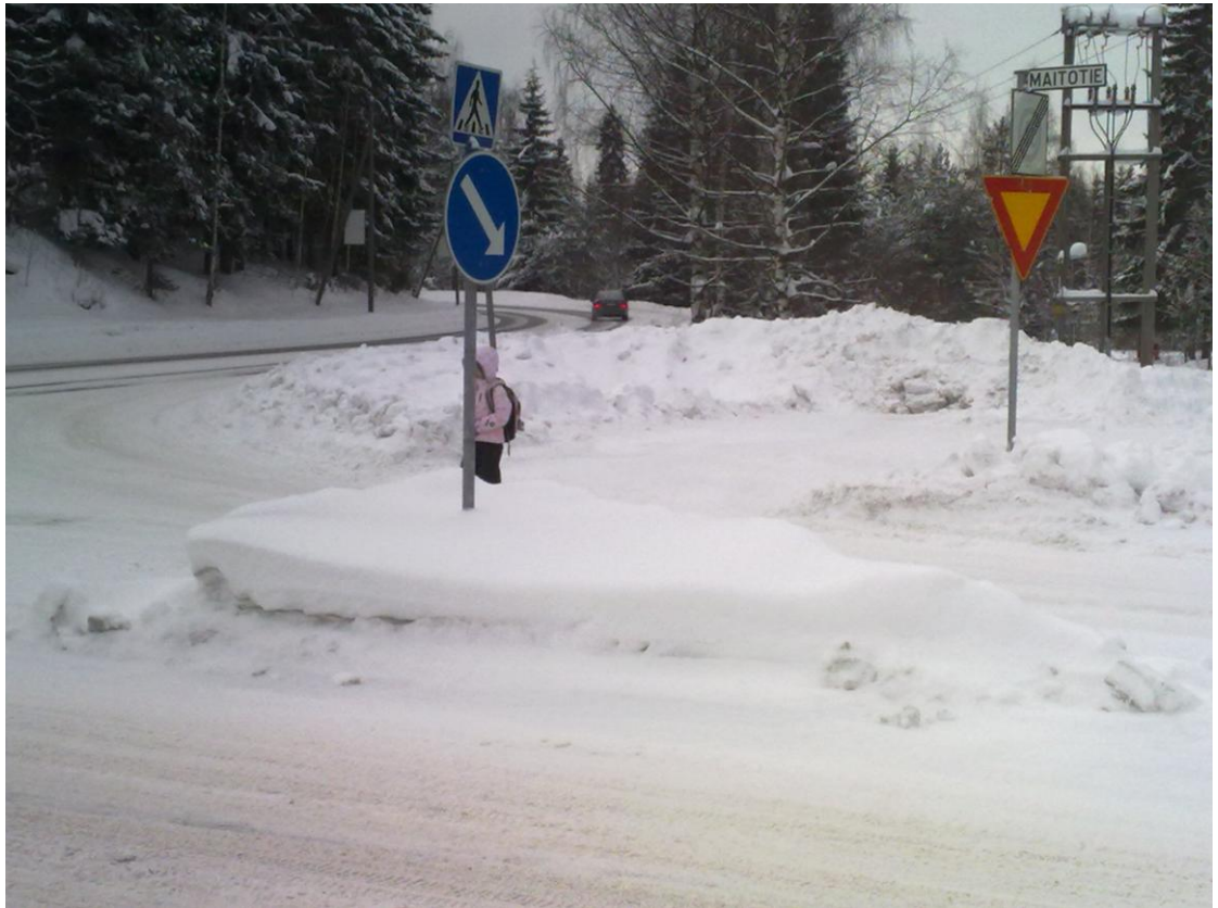
Kuva 17. Näkemäalue Jynkässä suoja-atiellä. Tavoiteltuun laatuun ei ole päästy kovien lumisateiden vuoksi.
