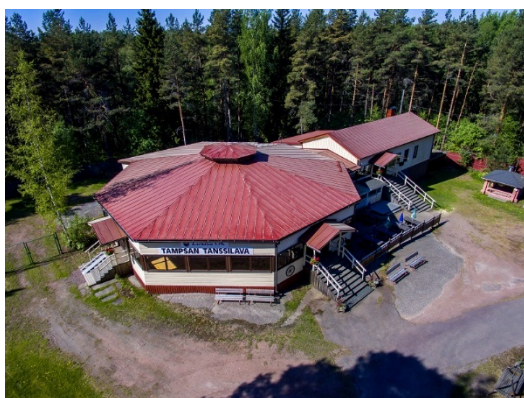
Kuva 12. Tanssi- ja viihdelava Tampsa. Kotka.
