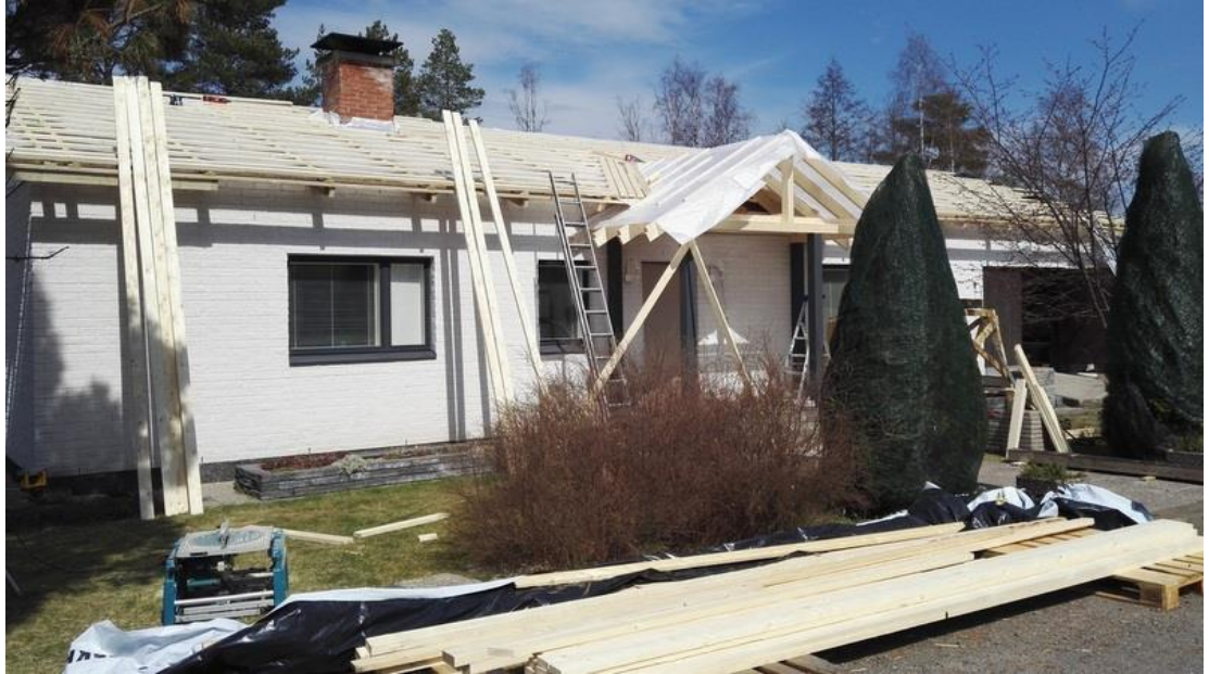
Kuva 28. Esimerkkikohteen 1 ruoteiden asennusta. (Jokinen 2017-05)
