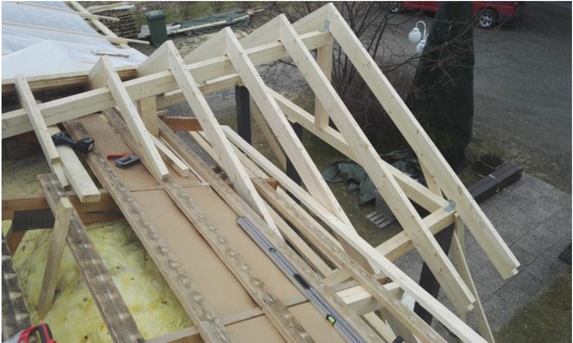
Kuva 16. Esimerkkikatto 1 Vesikaton uusimisen yhteydessä toteutettiin pääsisäänkäynnin terassin laajennus. (Jokinen 20017-05)
