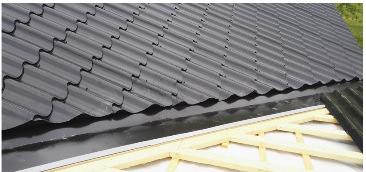
Kuva 41. Katelevyjen asennusta sisäjiirissä esimerkkikohteessa 1. (Jokinen 2017-05)
