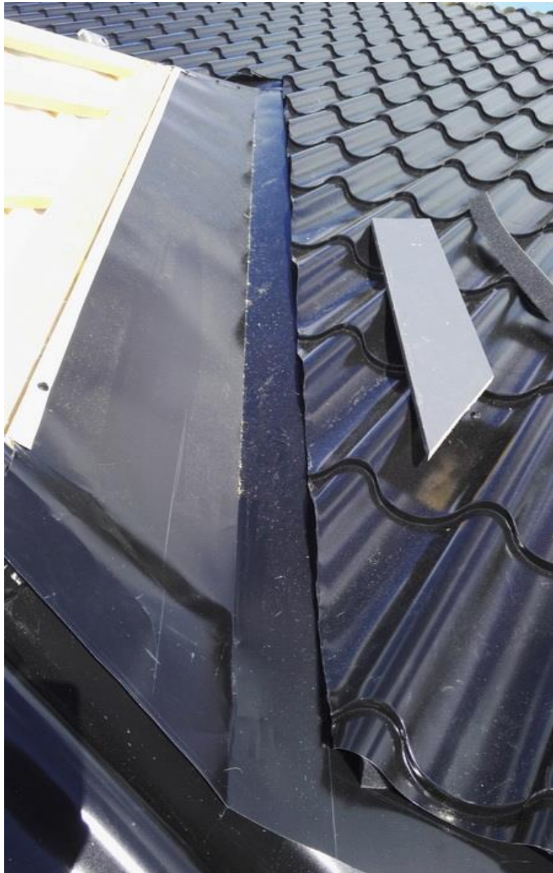
Kuva 42. Katelevyjen asennusta lappeelle päättyvässä sisäjiirissä. (Jokinen 2017-05)
