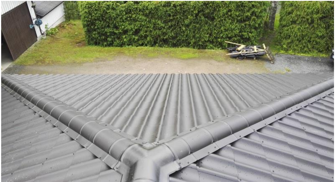
Kuva 46. Esimerkkikaton 2 auman ja harjan pellitykset asennettu. (Jokinen 2017-06)
