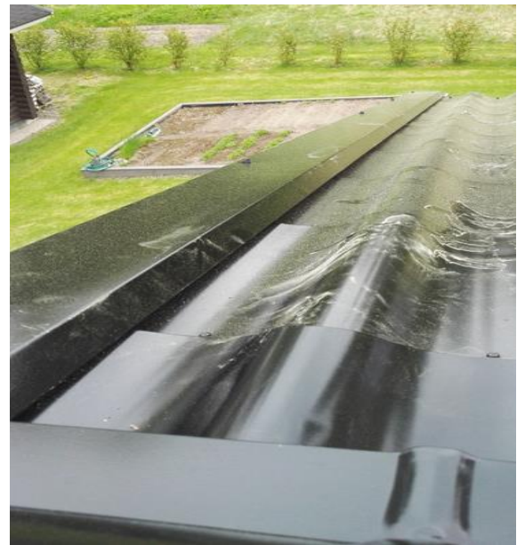
Kuva 44. Kiinnitetty päätypelti viimeistelee ulkonäköä, suojauksen lisäksi. (Jokinen 2017-05)
