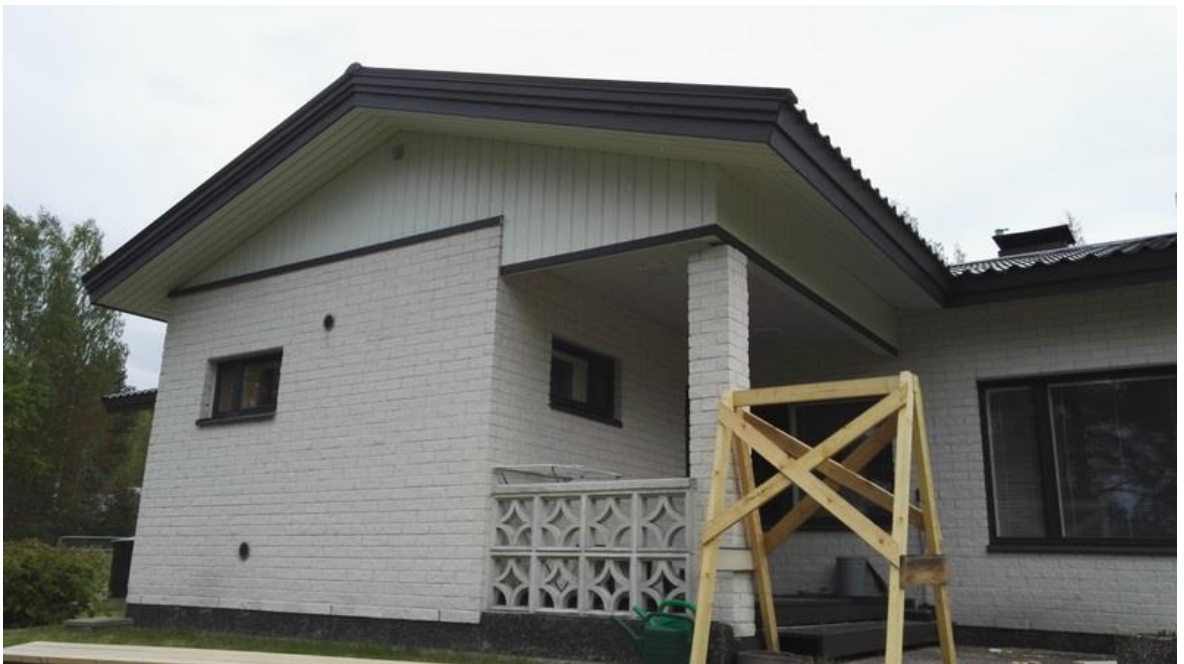
Kuva 32. Esimerkkikohteen 1 räystäänaluslaudat viimeistelevät ulkonäön. (Jokinen 2017-05)
