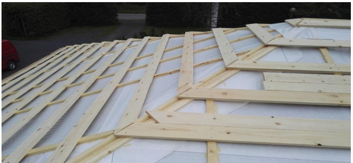
Kuva 27. Auman eli ulkojiirin ruoteet asennettu. (Jokinen 2017-06)
