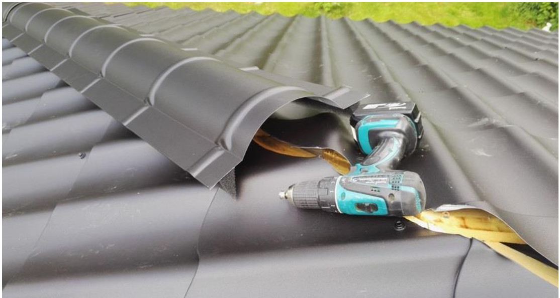
Kuva 45. Auman tiivistys ja sauman peittäminen tehdään tiivisteellisillä harjalistoilla. (Jokinen 2017-06)
