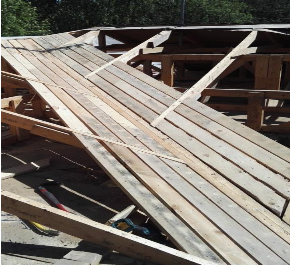
Kuva 19. Esimerkkikatossa 2 Jiirinpohja laudoitettiin kattotuolien kanssa samaan tasoon, jotta aluskate ei jää pussille kattotuolien väliin. (Jokinen 2017-06)
