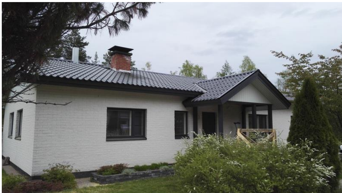
Kuva 1. Esimerkkikohde 1 johon tehtiin laaja kattoremontti. (Jokinen 2017-05)
