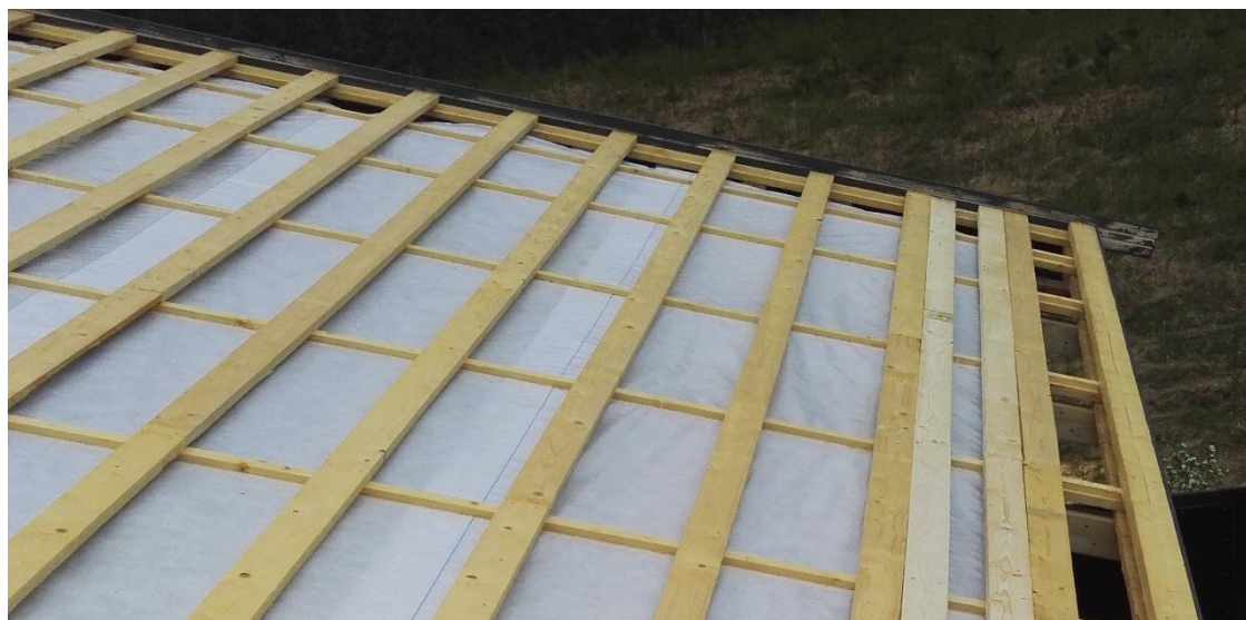
Kuva 31. Uloin päätyräystäslauta asennetaan muotolevykatteen kokonaiskorkeuden verran ruoteiden yläpuolelle. (Jokinen 2017-05)
