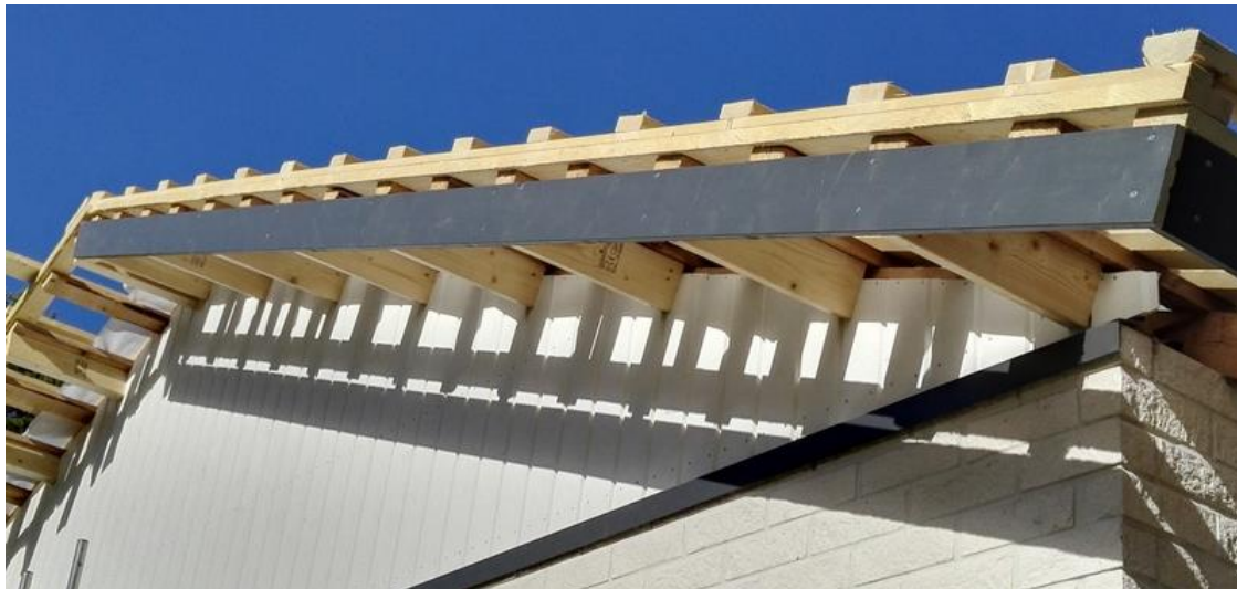
Kuva 30. Päätyräystäslautojen asennusta esimerkkikohteessa 1. (Jokinen 2017-05)
