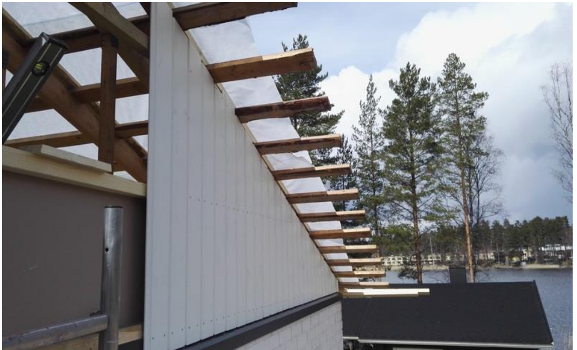
Kuva 18. Esimerkkikatto 1 päätykolmioiden panelointi uusittiin ja lisäeristettä varten asennettiin tuulensuojalevy. (Jokinen 2017-05)
