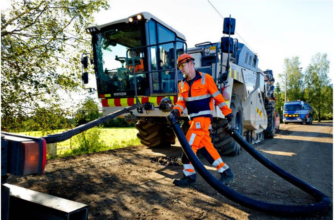
Kuva 9. Stabilointia Kauhajoki-Honkajoki välillä. (Kuva: Lemminkäinen)
