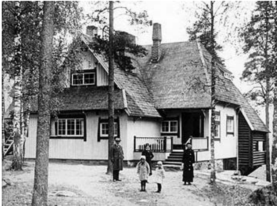
KUVA 11. Ainola laajennuksen ja vuorilaudoituksen jälkeen 1915 (Hartikainen & Sirén).
