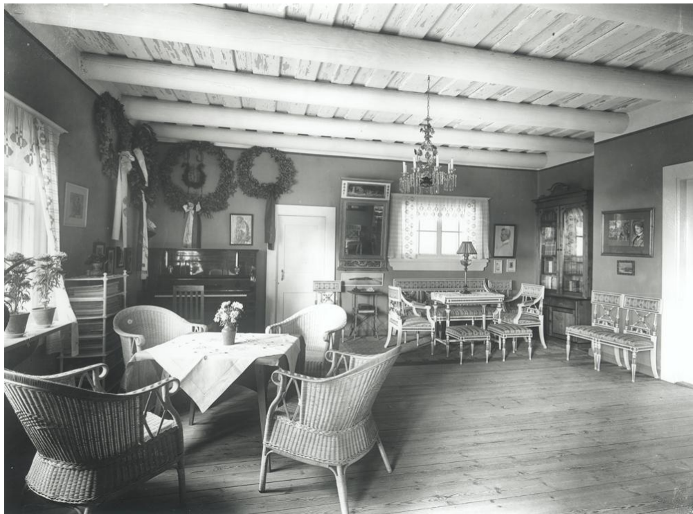
KUVA 41. Sali vuonna 1915. Kattolautojen maalipinta hilseilee pahoin. (Sundström 1915.)
