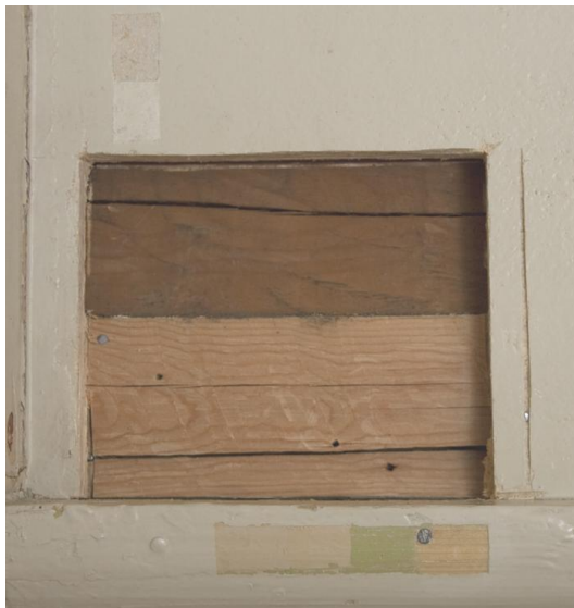
KUVA 15. Keittiön seinälevyn avaus. Levyseinän takana ainoastaan seinähirret ja luultavasti levyn naulausta varten lisätty, hirren raon peittävä puurima.
