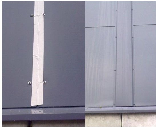
Kuva 18. Elementtisauman tiivistys butyylinauhalla ja saumakohdan pystypellitys.
