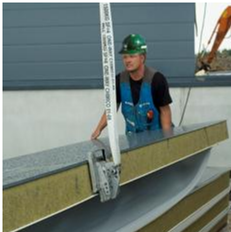
Kuva 15. Urosponttiin kiinnitettävä LiftAid HF 8-20 /5/.
