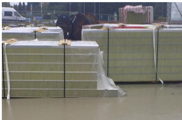
Kuva 11. Elementtipakkauksen toinen pääty on lammikossa ja elementti käyttökelpoton.
