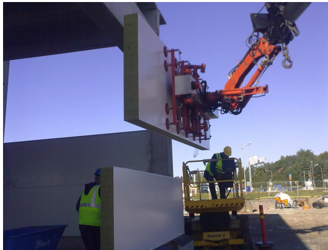
Kuva 14. Elementtien asennus alipainenostimella.
