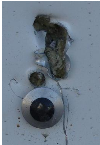
Kuva 33. Esiporatut kiinnikereivät eivät jostain syystä ole onnistuneet.
