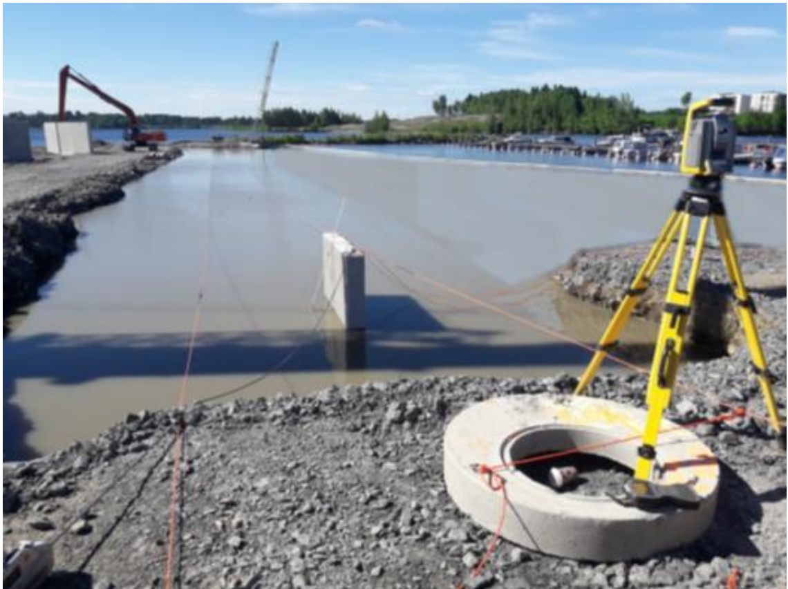
KUVA 12. Elementin paikalleen mittaus.
