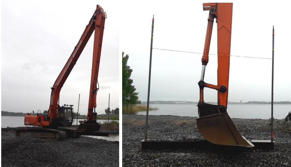
KUVA 9. Pohjien teossa käytettävä kaivinkone, jonka kauhassa on teräspalkki
