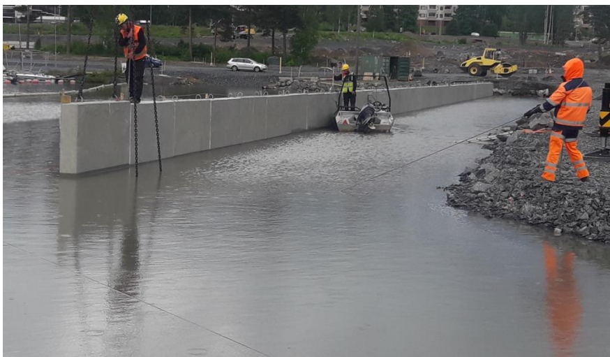
KUVA 14. Elementin asennusta paikalleen.
