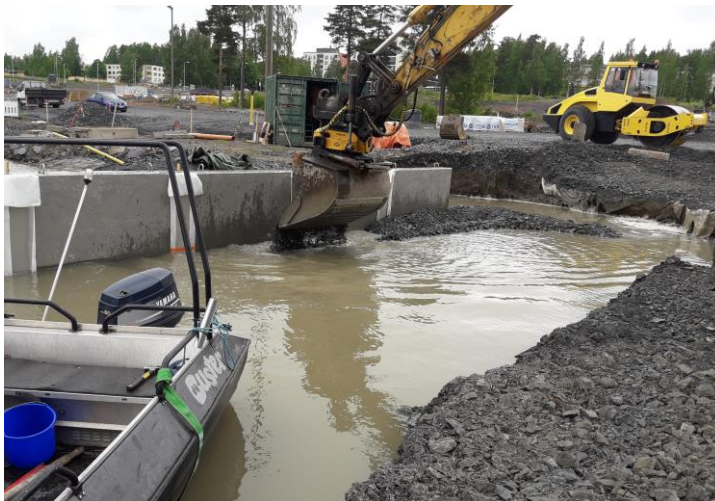
KUVA 15. Teräslevyt asennettu ja taustatäytön tekoa.
