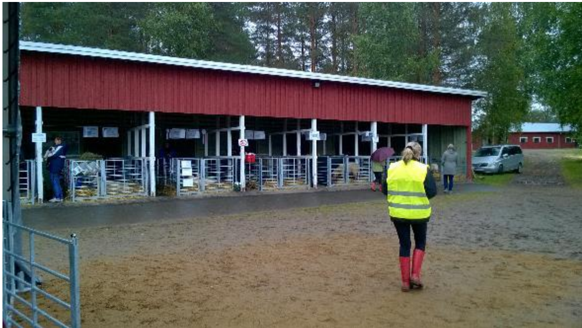
KUVA 10. Valjastuskatoksen rakennetut pässiaitaukset (Repo 2017-09-08)
