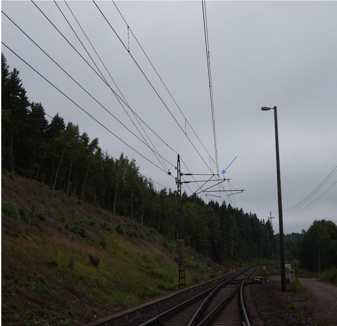
Kuva 11. Kuvassa nähdään hyvin sivuraiteen kohtaamisjälteen yhdistyminen pääraiteeseen siniten nuolen kärjen kohdalla.
