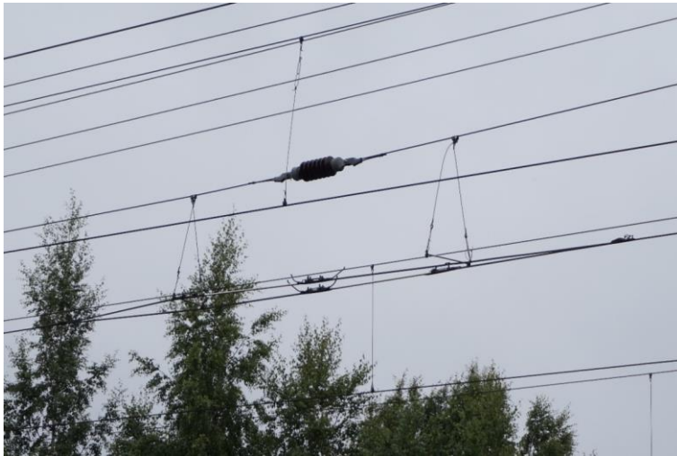
Kuva 9. Ryhmityseristin Lielahden liikennepaikalla.
