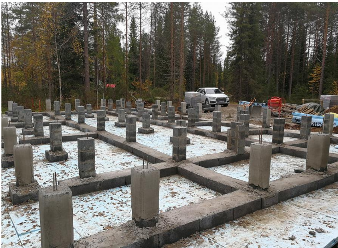
KUVA 3. Päärakennuksen perustukset (Vuolteenaho 2017-09-24.)
