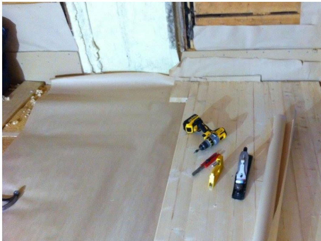
KUVA 8. Lattialankkujen asennusta
