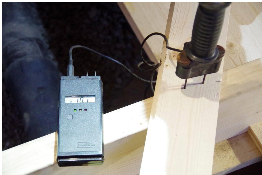
KUVA 7. Kosteuden mittausta lattialankusta
