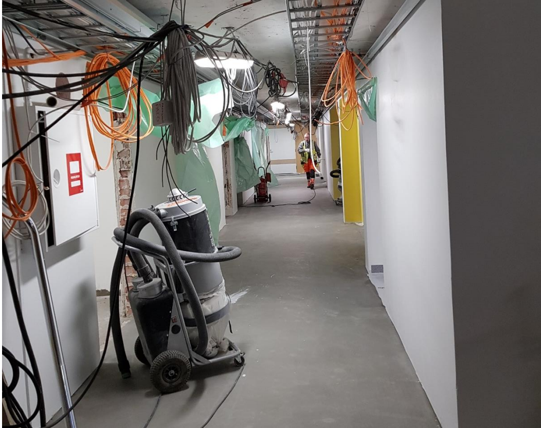
Kuva 6. Työmaan 2. vaiheen käytävä kuvassa
