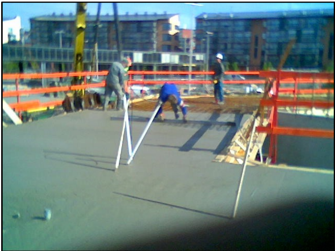
Kuva 1. Kanavanneidon holvia valetaan NP-betonilla kesällä vuonna 2006
