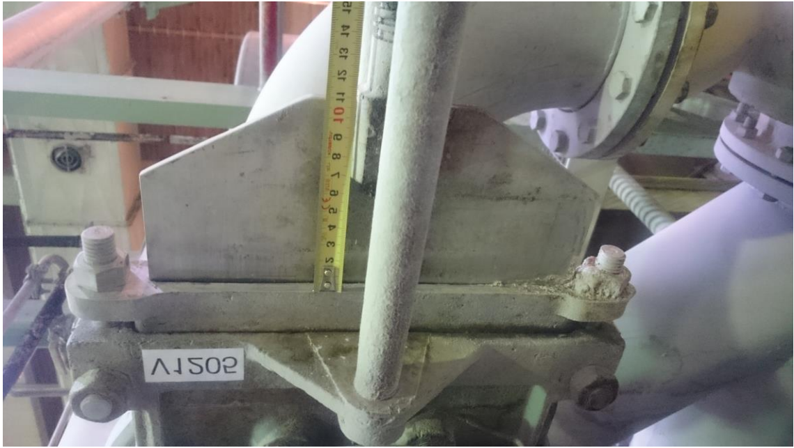
KUVA 8. Venttiilin säädön mittaaminen. (Kuva: Laura Warjus 2017)
