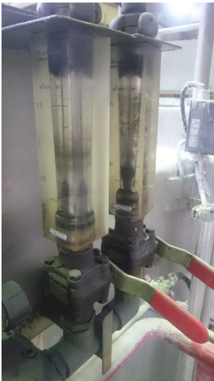
KUVA 5. Kennojen 1 ja 3 ilmastuksen säätö käsiventtiileillä ja mittaus rotametreillä (Kuva: Laura Warjus 2017)
