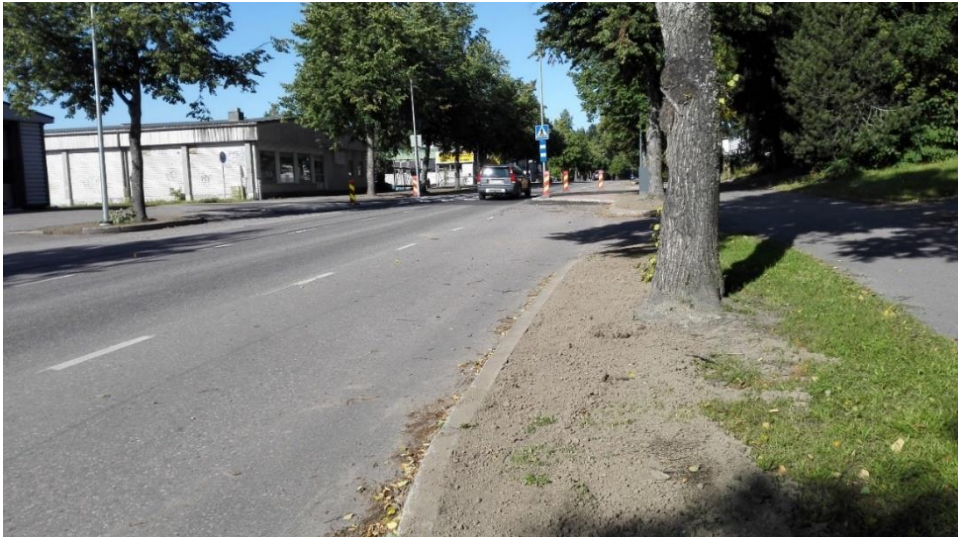
Kuva 24. Relanderinkadun kavennuksen rakentamisen yhteydessä viherkaistoille lisättiin kasvualustaa. (Tuovinen 2017.)
