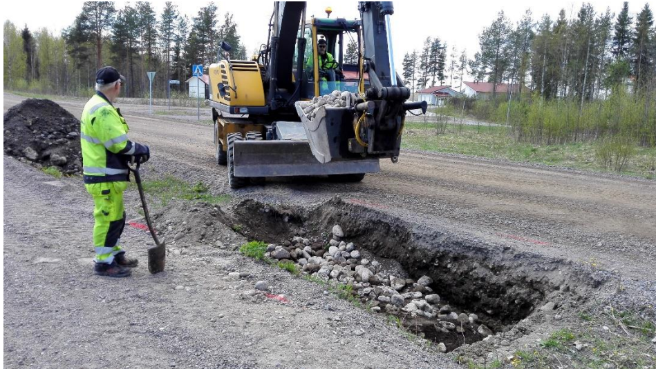
Kuva 6. Varkaudessa, Harjulantielle rakennettiin kantava kasvualusta toukokuussa 2017. (Tuovinen 2017.)
