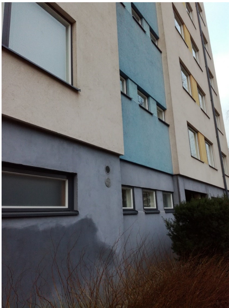
Kuva 16. Sisäänkäynnin julkisivun yleiskuva.
